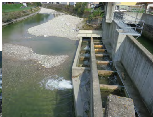
Abbildung 41: Wehrschwelle Kommetsrüti (links) mit rechtsufrigem Beckenpass (rechts).
