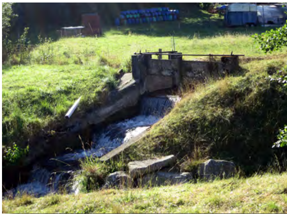
Abbildung 29: Schwellenserie bei der ehemaligen Wasserfassung der Mühle Pfaffnau (94001).
