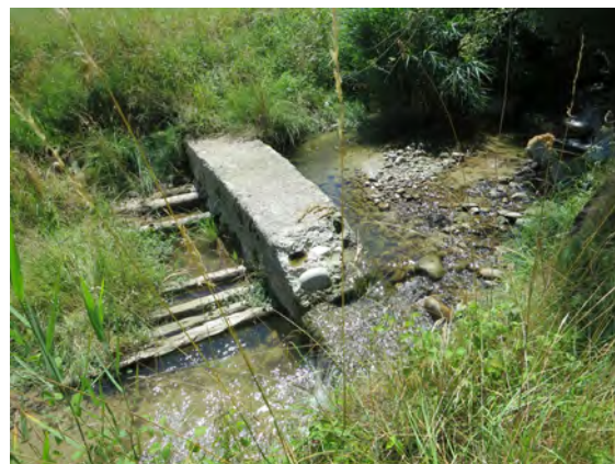
Abbildung 44: Wasserfassung der Mühle Wicki (2008) im Blattbach.
