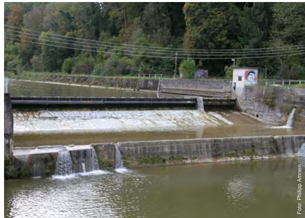
Abbildung 38: Wehranlage des Kraftwerks Emmenweid.
