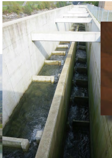
Abbildung 40: Wehr und Maschinenhaus des Kraftwerks Ettisbühl (2003, links), Verticalslot-Fischpass mit Beobachtungsfenster für die Funktionskontrolle).
