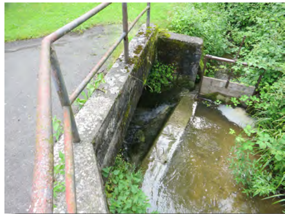
Abbildung 10: Künstlicher Absturz (links) der Seitenentnahme mit Schieber der Ferrenmühle (70004).
