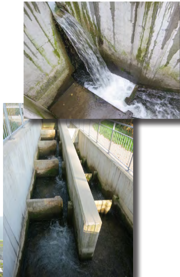
Abbildung 24: Wehr Gettnau (links), Vertical-Slot-Fischpass (Mitte) und schlecht geführter Fischabstieg direkt in ein Becken des Fischpasses.
