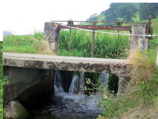
Abbildung 20: Glatte Sohlrampe bei der Steinermühle (40003), sowie künstlicher Absturz beim Wasserteiler Mühlekanal/Schwefelbach.
