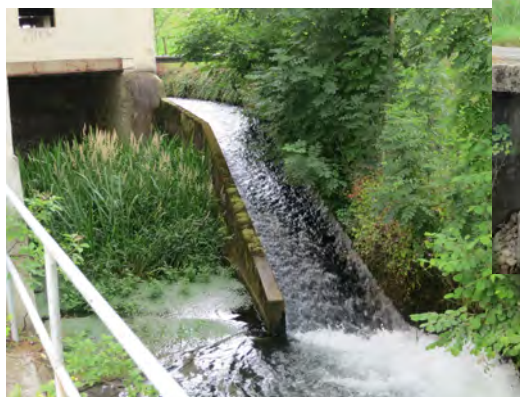
Abbildung 20: Glatte Sohlrampe bei der Steinermühle (40003), sowie künstlicher Absturz beim Wasserteiler Mühlekanal/Schwefelbach.
