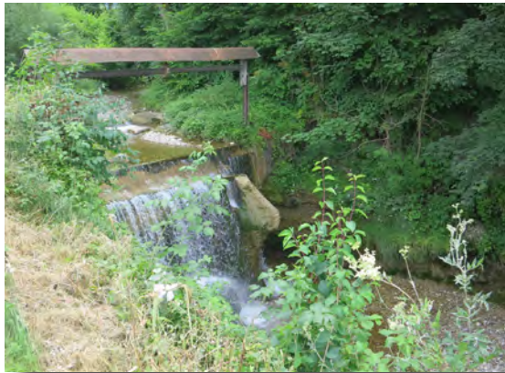
Abbildung 26: Natürlicher Absturz bei der Seitenentnahme der Mühle Luthern (43205).
