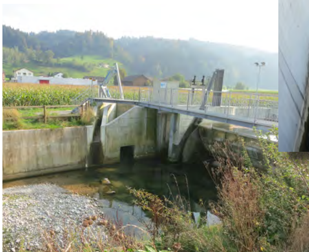
Abbildung 24: Wehr Gettnau (links), Vertical-Slot-Fischpass (Mitte) und schlecht geführter Fischabstieg direkt in ein Becken des Fischpasses.
