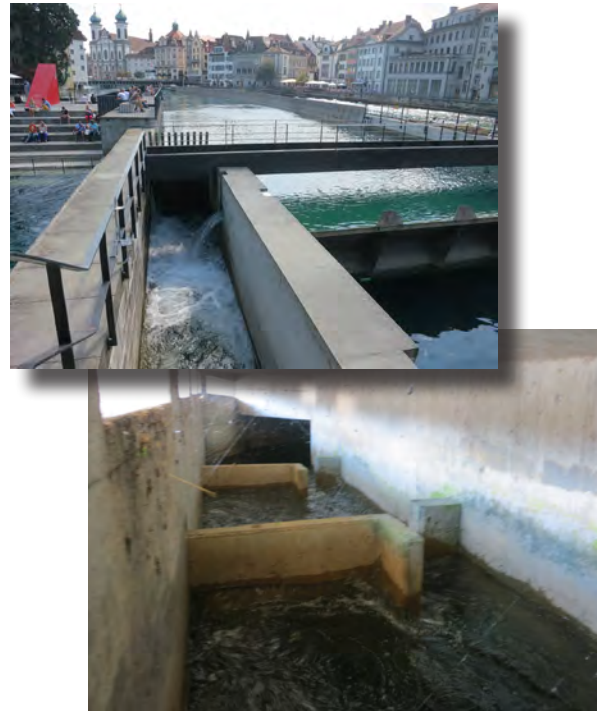
Abbildung 33: Regulierwehr und Fischabstiegshilfe des Kraftwerks Mühleplatz, Stadt Luzern (10004, oben), sowie Vertical-Slot-Beckenpass am rechten Reussufer (unten).
