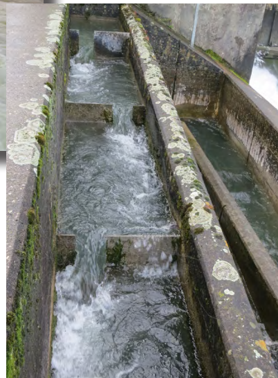
Abbildung 32: Wehr Rathausen in der Reuss (oben), sowie der rechtsufrig liegende veraltete Beckenpass (rechts).
