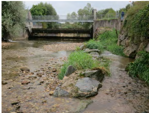
Abbildung 19: Fehlende Leitströmung, (links), sowie veralteter Beckenpass mit Schlupfloch (oben) der Fischaufstiegshilfe beim Wehr des KW Lang, Reiden (40001) in der Wigger.
