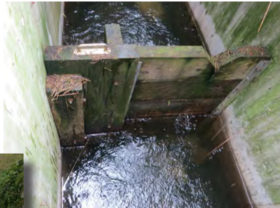
Abbildung 19: Fehlende Leitströmung, (links), sowie veralteter Beckenpass mit Schlupfloch (oben) der Fischaufstiegshilfe beim Wehr des KW Lang, Reiden (40001) in der Wigger.
