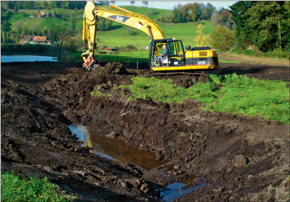
Mit Baggereinsatz wird ein neuer Weiher geschaffen.
