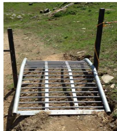
Weideroste eignen sich auf häufiger befahrenen Wegen oder Strassen durch Weiden mit Gross- und Kleinvieh. Die Passage auf dem zweiten Bild bewährt sich insbesondere bei häufiger Nutzung durch Fahrradfahrer.
