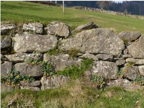
Herkömmliche Trockensteinmauer
