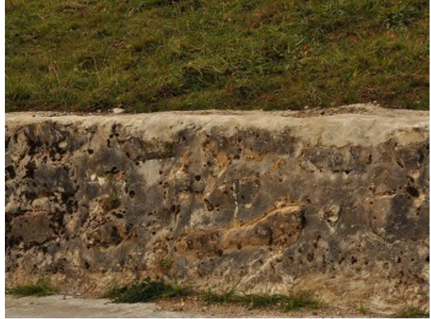
Betonierte, verfugte Stützmauer mit Natursteinen
