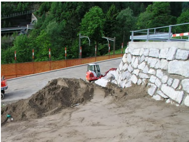
Moderne, mit Maschinen errichtete Zyklopenmauern
