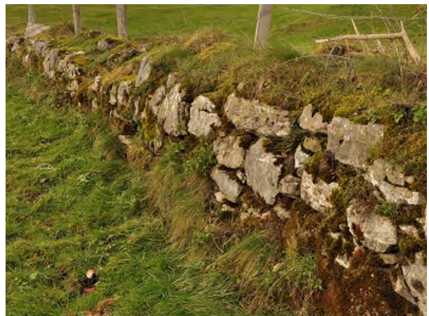
Herkömmliche Trockensteinmauer
