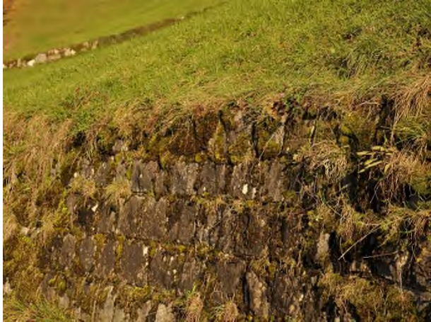
Mit Mörtel verfugte Stützmauer aus einheitlichen, industriell hergestellten Steinen
