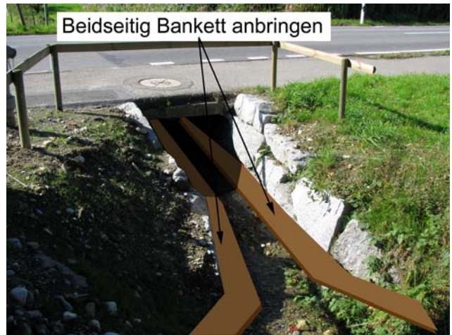
Foto 1-4: Dritter Gewässerdurchlass des Heuschtgrabens bei der Kantonsstrasse K16 (Massnahme GD3)
