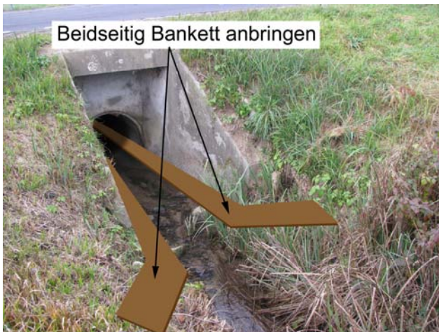
Foto 1-5: Gewässerdurchlass des Heuschtgrabens bei der Kantonsstrasse K58 (Massnahme GD4)
