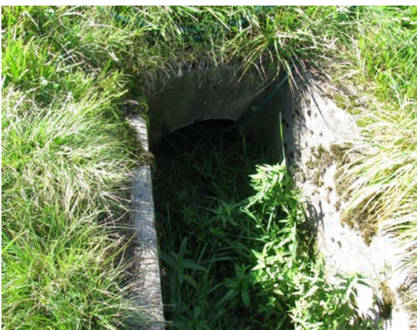
Foto 1-1: Erster Gewässerdurchlass des Heuschtgrabens bei der Kantonsstrasse K16 (Massnahme GD1: in heutigem Zustand belassen)
