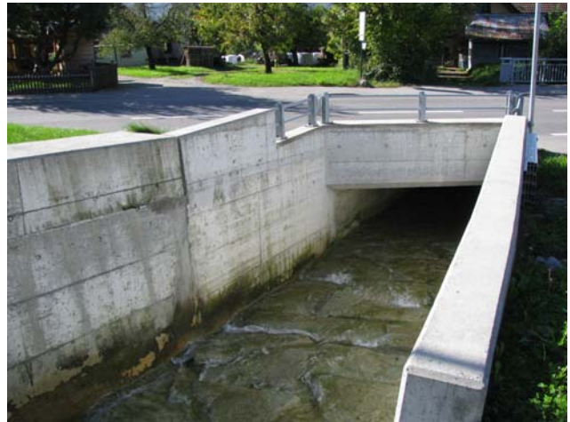
Foto 1-10: Gewässerdurchlass Altwiserbach bei der Kantonsstrasse K16
