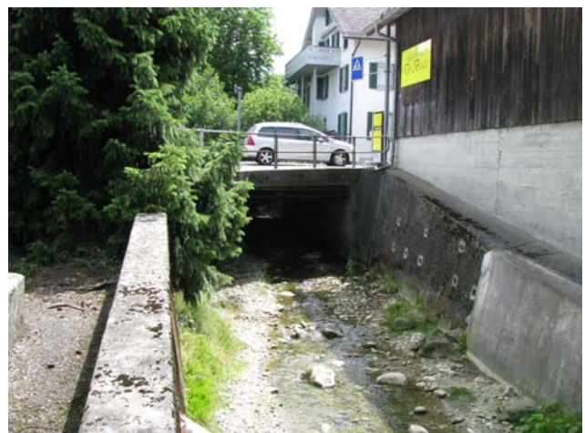
Foto 1-8: Vorderbach durch Aesch beim Gewässerdurchlass der Kantonsstrasse K16
