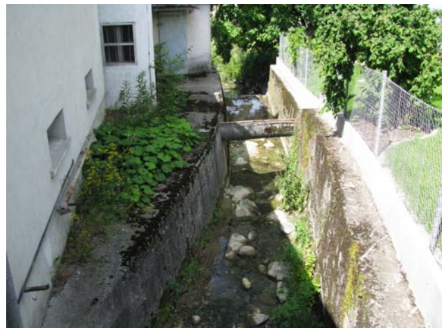
Foto 1-6: Hinterbach durch Aesch beim Gewässerdurchlass der Kantonsstrasse K16
