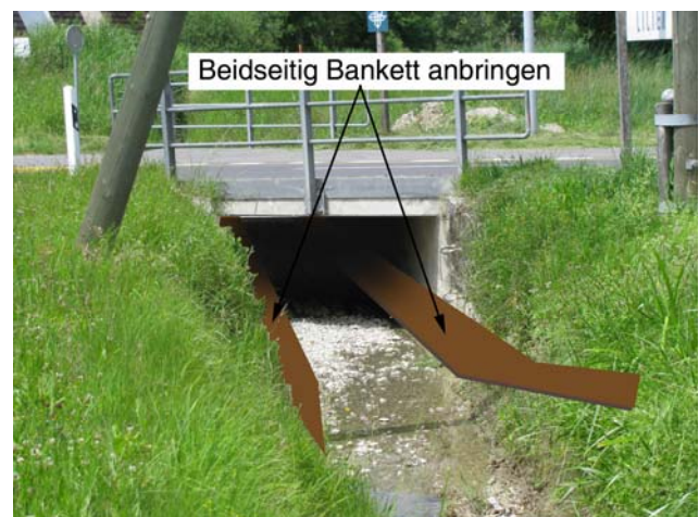
Foto 2-2: Gewässerdurchlass Altwiserbach bei der Kantonsstrasse K58 (Massnahme GD2)
