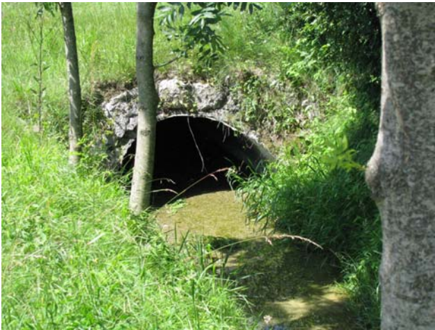
Foto 2-3: Gewässerdurchlass Altwiserbach bei der Strasse Mosen-Altwis, Blickrichtung Nord-Westen
