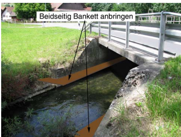
Foto 2-1: Gewässerdurchlass Aabach bei der Kantonsstrasse K58 (Massnahme GD1)
