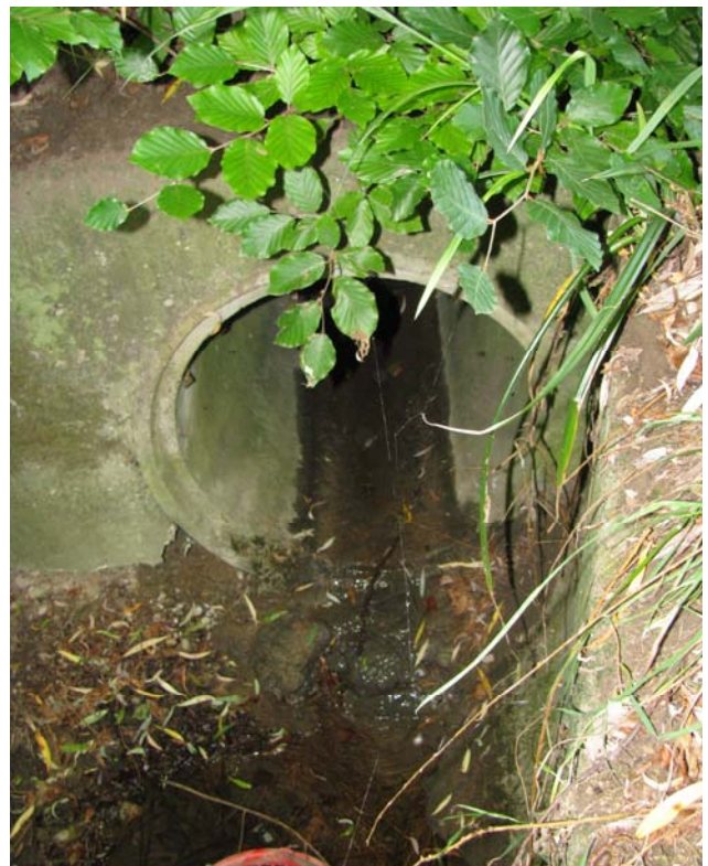
Foto 3-2: Gewässerdurchlass des Vorderdorfbachs an der Kantonsstrasse K16a und der Eisenbahnlinie (Massnahme GD1: in heutigem Zustand belassen)
