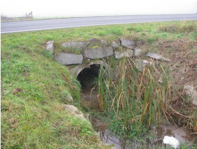
Foto 3-5: Gewässerdurchlass des Vorderreingrabens an der Kantonsstrasse K16a und der Eisenbahnlinie (Massnahme GD4: in heutigem Zustand belassen)
