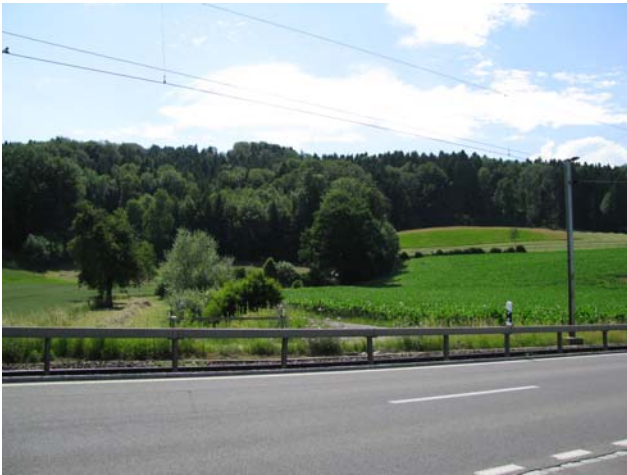
Foto 3-3: Bach mit Gewässerdurchlass an der Kantonsstrasse K16a und der Eisenbahnlinie (Massnahme GD2: in heutigem Zustand belassen)
