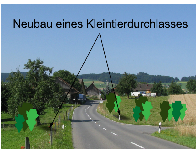
Foto 5-1: Kantonsstrasse K57a östlich der Siedlung Niederwil (Massnahme NB1)
