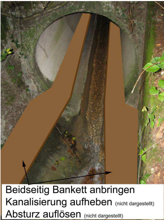
Foto 6-2: Gewässerdurchlass Gründelbach an der Kantonsstrasse K14 (Massnahme GD2)
