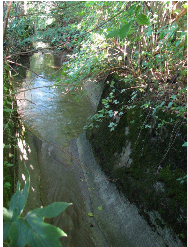
Foto 6-3: Kanalisierter Gründelbach unterhalb des Gewässerdurchlasses an der Kantonsstrasse K14 (Massnahme GD2)
