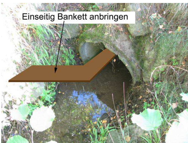
Foto 6-1: Gewässerdurchlass Hangbach an der Kantonsstrasse K14 (Massnahme GD1)
