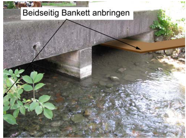
Foto 7-6: Gewässerdurchlass Aabach im „Oberdorf“ des Siedlungsgebiets Ermensee (Massnahme GD5)
