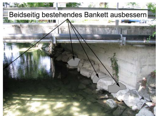
Foto 7-2: Gewässerdurchlass Aabach an der Strasse Retschwil – Richensee (Massnahme GD2)
