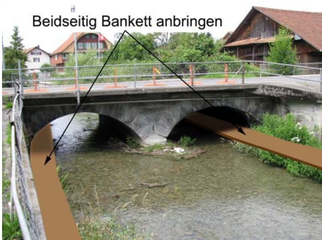
Foto 7-1: Gewässerdurchlass Aabach an der Kantonsstrasse K16a (Massnahme GD1)
