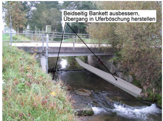
Foto 8-4: Gewässerdurchlass Ron bei Strasse Ober Huwil – Hochdorf (Massnahme GD4)
