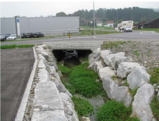
Foto 8-5: Gewässerdurchlass Birgenbach bei Industriegebiet Ron (Massnahme GD3: Gewässerdurchlass in heutigem Zustand belassen)
