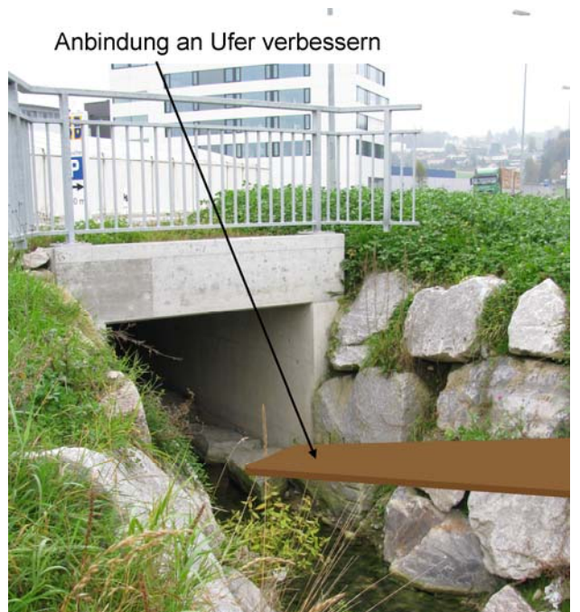
Foto 8-7: Gewässerdurchlass Birgenbach bei Kantonsstrasse K56 (Massnahme GD2)
