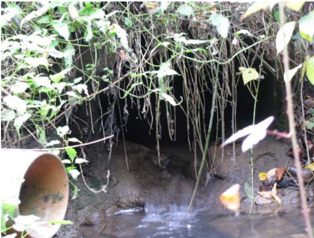
Foto 9-3: Gewässerdurchlass bei Feldweg, der von der Strasse Rothenburg – Eschenbach abzweigt (Massnahme NB3: Neubau des Gewässerdurchlasses)
