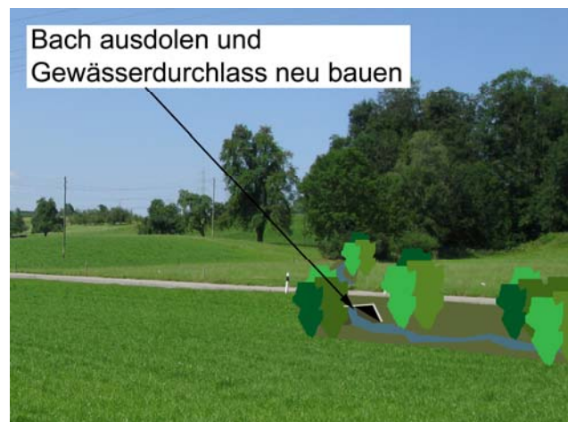
Foto 9-2: Massnahme NB2: Neubau eines Gewässerdurchlasses an der Strasse Rothenburg – Eschenbach, sowie Massnahme AD1: Ausdolen des Bachs
