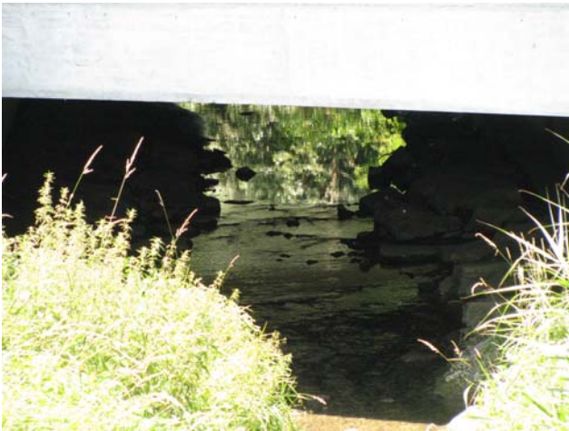
Foto 10-3: Beidseitig vorhandenes Bankett beim Gewässerdurchlass Waldibach an der Kantonsstrasse K16 und der Eisenbahnlinie
