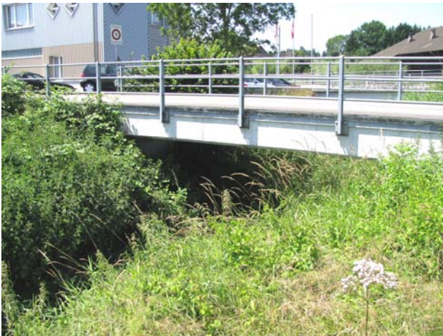
Foto 10-5: Gewässerdurchlass Waldibach beim Industriegebiet Waldibrücke (Massnahme GD2: in heutigem Zustand belassen)
