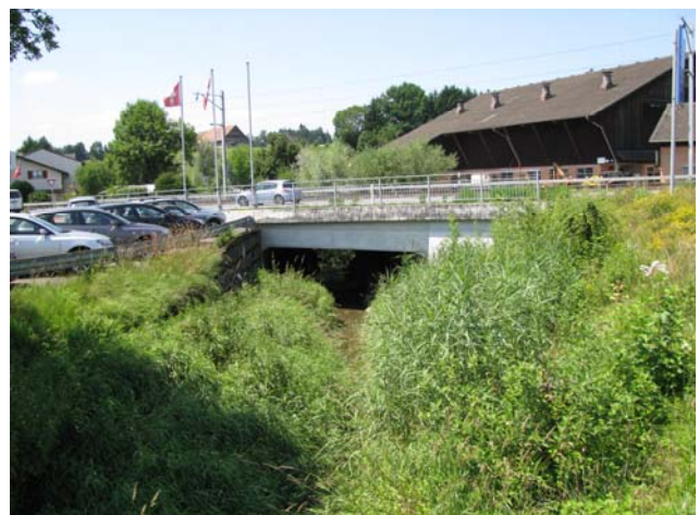
Foto 10-2: Gewässerdurchlass Waldibach an der Kantonsstrasse K16 und der Eisenbahnlinie (Massnahme GD1: in heutigem Zustand belassen)
