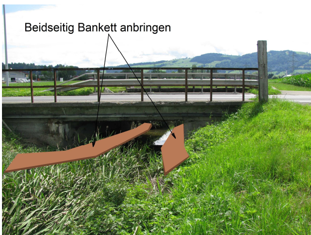
Foto 11-1: Gewässerdurchlass Mülibach an der Kantonsstrasse K65 (Massnahme GD1)
