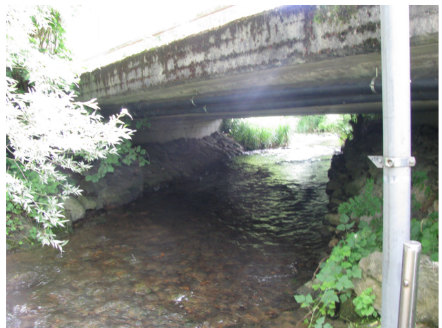
Foto 12-2: Gewässerdurchlass Stägbach an der Seebadstrasse (Massnahme GD2: Durchlass in heutigem Zustand belassen)
