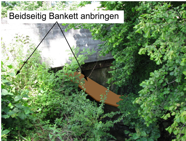
Foto 12-3: Gewässerdurchlass Stägbach an der Flurstrasse Hochdorf-Kleinwangen (Massnahme GD3)
