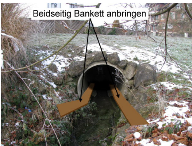
Foto 14-1: Gewässerdurchlass nördlich Eschenbach unter Kantonsstrasse K16 (Massnahme GD1)
