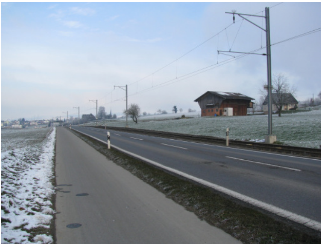
Foto 14-5: Kantonsstrasse K16 und Eisenbahnlinie; Massnahme NB2 (Neubau Kleintierdurchlass) wird in diesem Bereich vorgesehen
