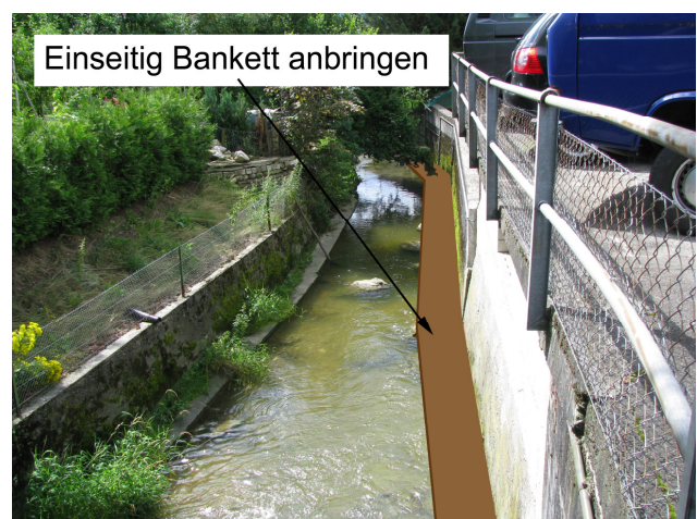
Foto 15-2: Schwinibach unmittelbar unterhalb des Gewässerdurchlasses an der Kantonsstrasse K65a (Massnahme GD1)
