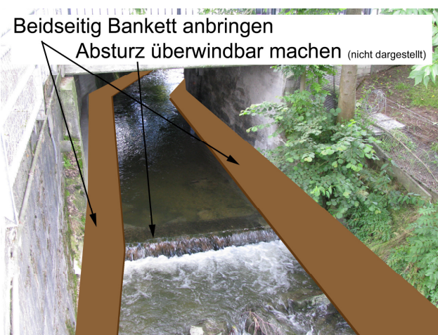
Foto 15-1: Gewässerdurchlass Schwinibach an der Kantonsstrasse K65a (Massnahme GD1)
