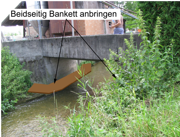
Foto 15-3: Gewässerdurchlass Schwinibach im Wohn- und Arbeitsgebiet Inwil (Massnahme GD2)
