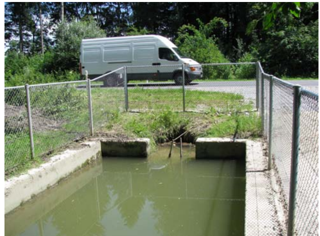
Foto 16-2: Gewässerdurchlass Seilergraben an der Kantonsstrasse K17a, mit Rückhaltebecken (Feuerwehrteich?)
