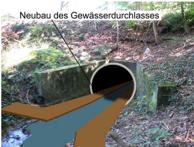
Foto 17-3: Zweiter Gewässerdurchlass Mühlebach an der Kantonsstrasse K56a (Massnahme GD2)
