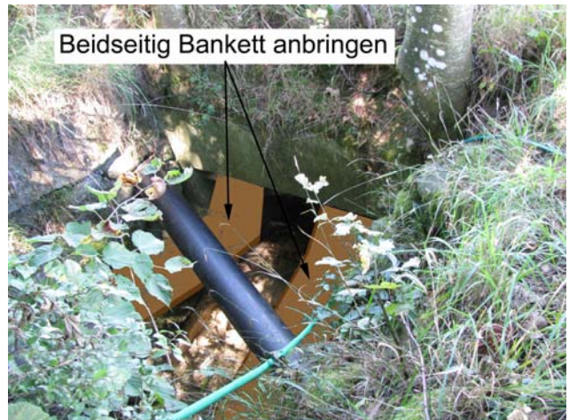
Foto 17-24: Gewässerdurchlass Burgbach an der Strasse Retschwil – Ermensee (Massnahme GD18)
