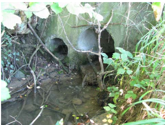
Foto 17-7: Erster Gewässerdurchlass Schorenbach an der Kantonsstrasse K56a (Massnahme GD6: in heutigem Zustand belassen)
