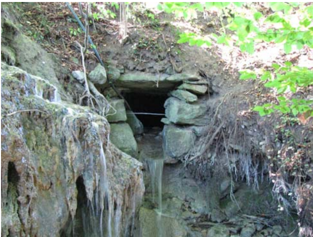
Foto 17-11: Zweiter Gewässerdurchlass Mühlenbach an der Strasse Römerswil - Ermensee (Massnahme GD10: Neubau des Gewässerdurchlasses inkl. Überwindbarmachung der Abstürze)
