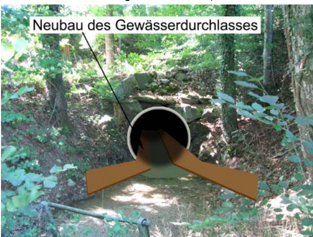
Foto 17-11: Zweiter Gewässerdurchlass Mühlenbach an der Strasse Römerswil - Ermensee (Massnahme GD10: Neubau des Gewässerdurchlasses inkl. Überwindbarmachung der Abstürze)
