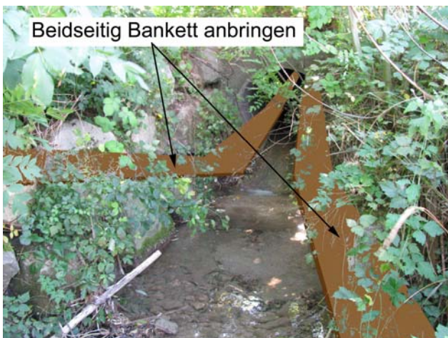
Foto 17-25: Gewässerdurchlass Schorenbach an der Strasse Retschwil – Ermensee (Massnahme GD19)
