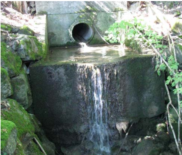
Foto 17-9: Gewässerdurchlass Steinmättelbach an der Kantonsstrasse K56a (Massnahme GD8: in heutigem Zustand belassen)
