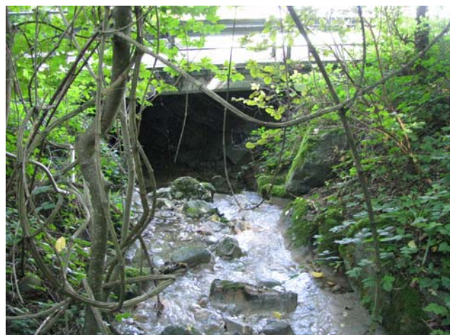
Foto 17-20: Gewässerdurchlass Steinmättelbach an der Strasse Römerswil - Ermensee
