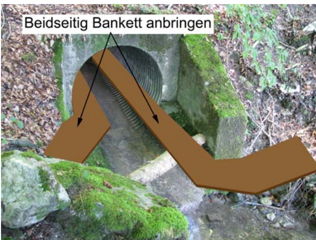
Foto 17-19: Gewässerdurchlass Schorenbach nahe der Strasse Römerswil - Ermensee (Massnahme GD15)
