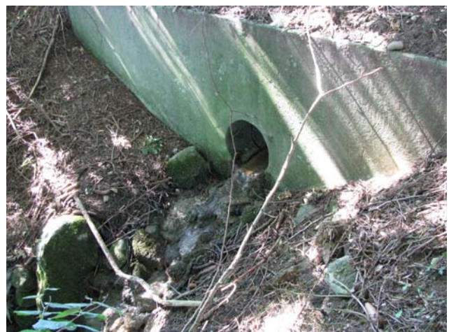
Foto 17-8: Zweiter Gewässerdurchlass Schorenbach an der Kantonsstrasse K56a (Massnahme GD7: in heutigem Zustand belassen)
