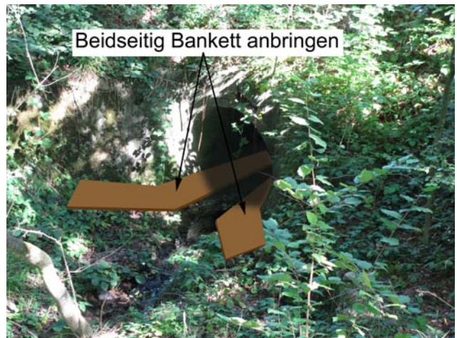
Foto 17-6: Zweiter Gewässerdurchlass Burgbach an der Kantonsstrasse K56a (Massnahme GD5)
