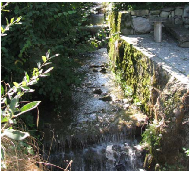
Foto 17-23: Stark verbauter Mühlenbach in der Nähe des Gewässerdurchlasses GD17
