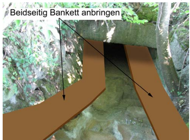
Foto 17-26: Gewässerdurchlass Steinmättelbach an der Strasse Retschwil – Ermensee (Massnahme GD20)
