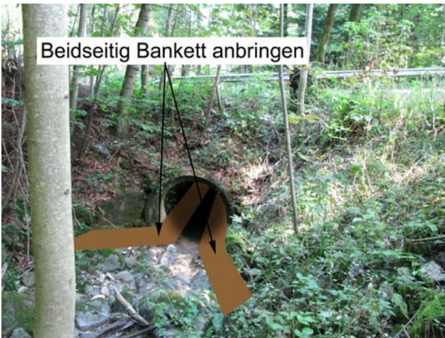
Foto 17-15: Erster Gewässerdurchlass Burgbach an der Strasse Römerswil - Ermensee (Massnahme GD12)
