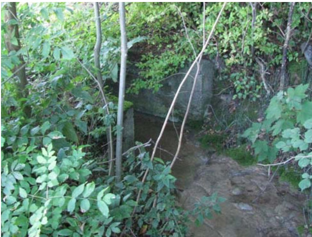
Foto 17-17: Gewässerdurchlass Schorenbach an der Strasse Römerswil - Ermensee
