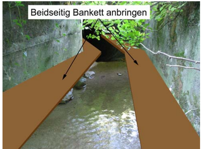
Foto 17-18: Gewässerdurchlass Schorenbach an der Strasse Römerswil - Ermensee (Massnahme GD14)
