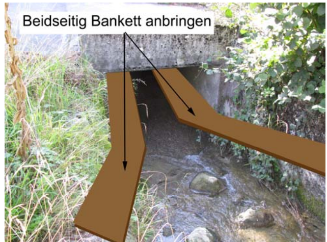
Foto 17-22: Gewässerdurchlass Mühlenbach an der Strasse Retschwil – Ermensee (Massnahme GD17)
