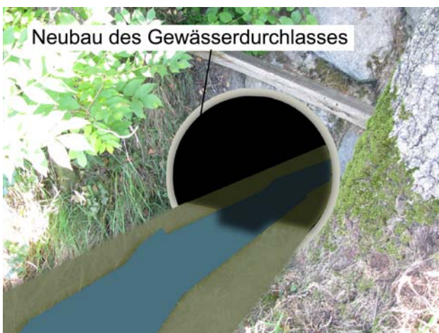
Foto 18-1: Erster Gewässerdurchlass unter Kantonsstrasse K15 hindurch (Massnahme GD1)
