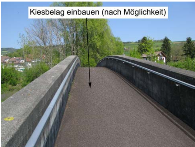
Foto 19-8: Fussgängerbrücke über die A2 (Massnahme ÜF1)
