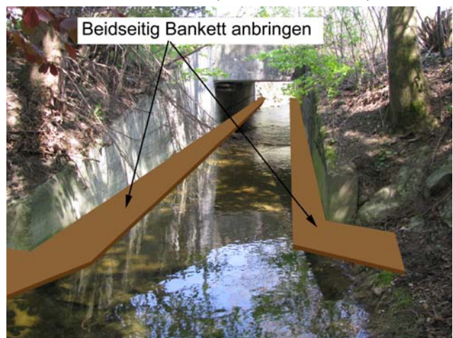
Foto 19-11: Gewässerdurchlass Greuelbach bei der Strasse Schenkön – Mariazell (Massnahme GD5)
