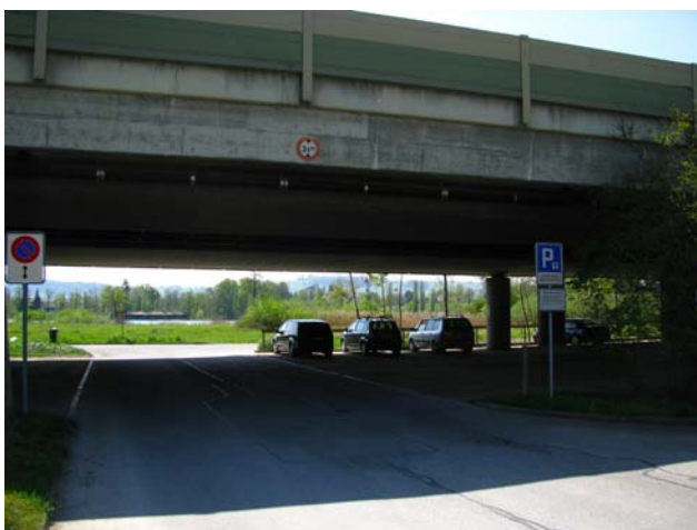
Foto 19-1: Unterführung Seeweg mit Parkplatz unter der Autobahn A2
