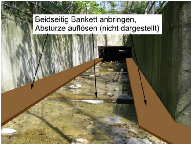
Foto 19-6: Gewässerdurchlass Lehntobelbach unter der A2 (Massnahme GD2)
