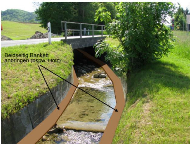
Foto 20-15: kanalisierter Chommlibach bei Zellfeld entlang der Kantonsstrasse K48 (Massnahme GD5)
