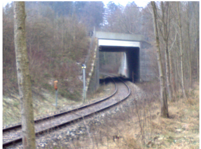
Foto 20-4: Bahnunterführung unter Autobahn
