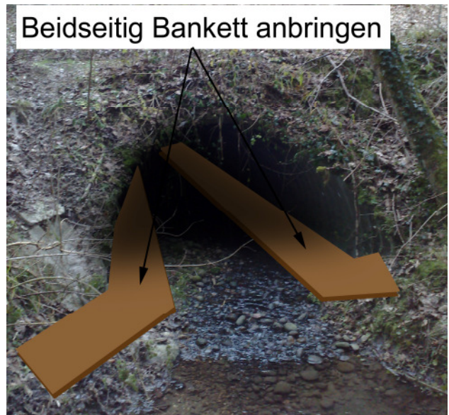
Foto 20-8: Gewässerdurchlass unter Autobahn (Massnahme GD2)
