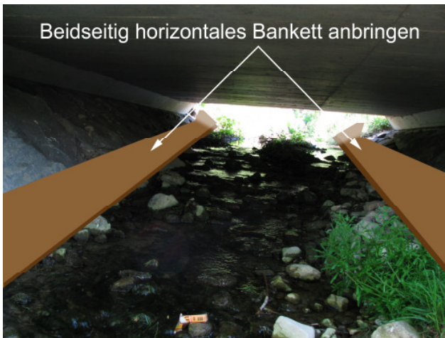
Foto 20-13: Gewässerdurchlass Hofstetterbach bei Kantonsstrasse K48 (Massnahme GD4)
