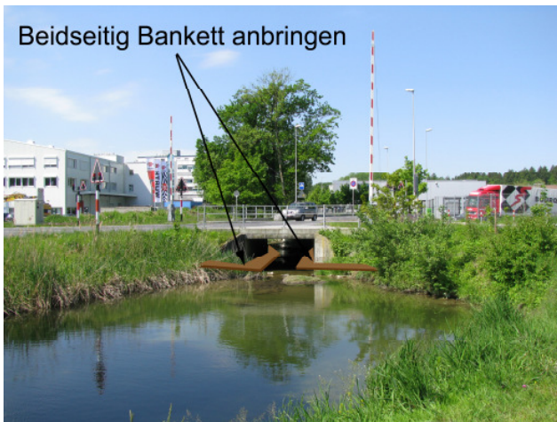
Foto 20-19: Gewässerdurchlass Chommlibach östlich des Industriegebiets Allmend (Massnahme GD8)
