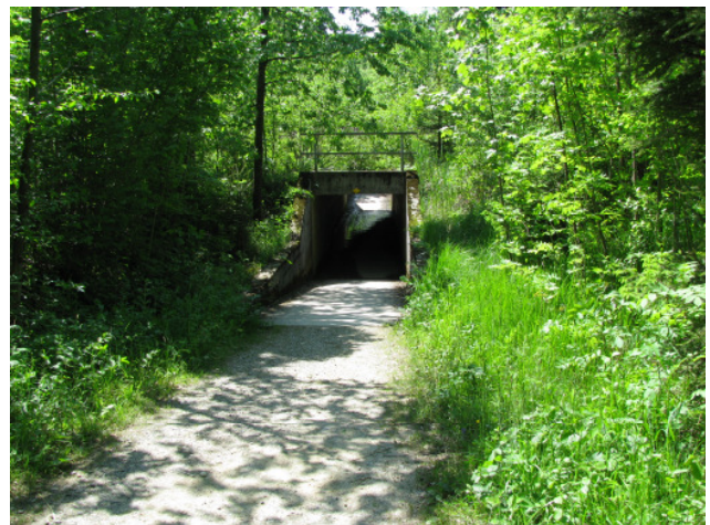
Foto 20-20: Unterführung unter Eisenbahn (Massnahme UF3: Naturboden einbauen)
