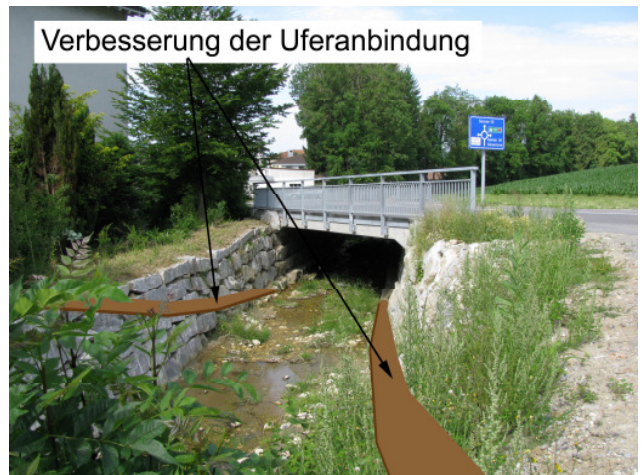
Foto 20-16: Gewässerdurchlass Chommlibach an der Kantonsstrasse K18 (Massnahme GD6)
