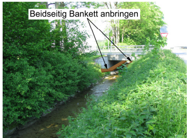
Foto 20-12: Gewässerdurchlass Chommlibach bei Kantonsstrasse K14 (Massnahme GD3)
