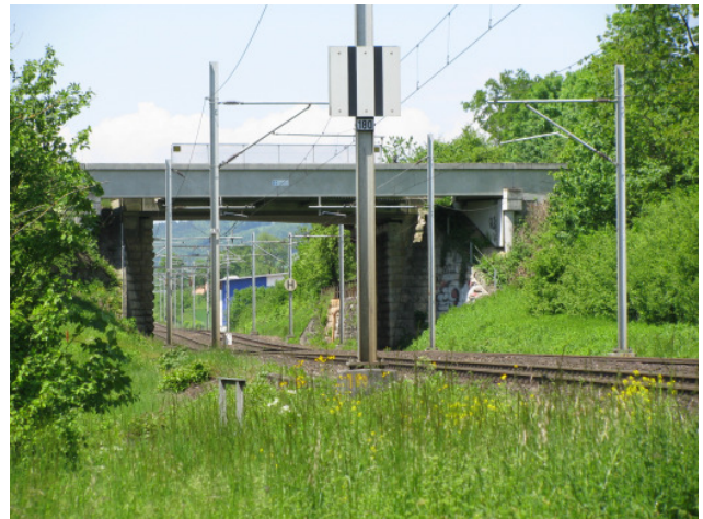
Foto 20-10: Brücke über die Eisenbahn
