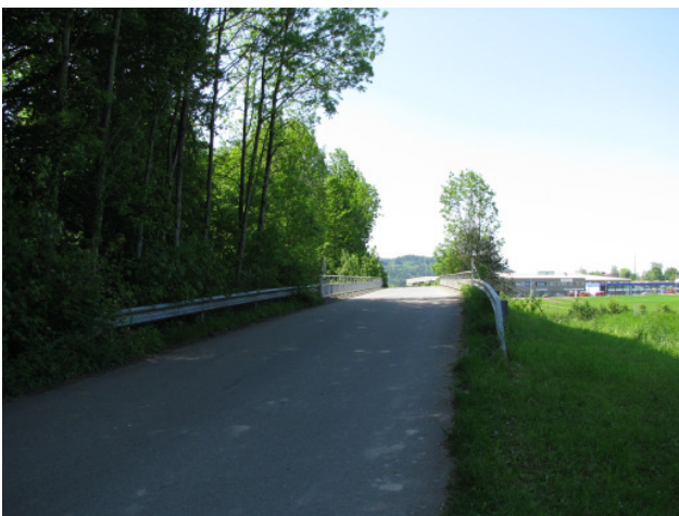
Foto 20-1: Brücke über Autobahn am westlichen Waldrand des Surseerwalds
