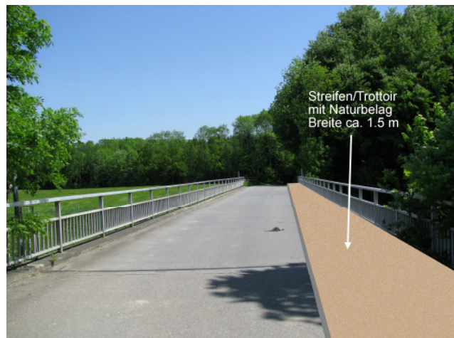
Foto 20-2: Brücke über Autobahn am westlichen Waldrand des Surseerwalds (Massnahme ÜF1)
