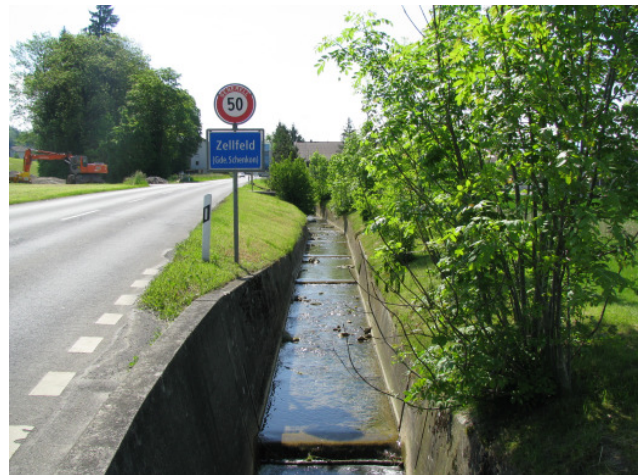
Foto 20-14: kanalisierter Chommlibach bei Zellfeld entlang der Kantonsstrasse K48
