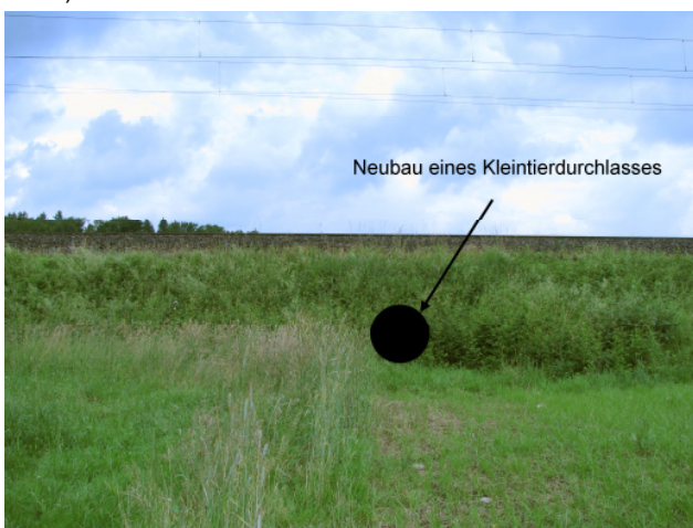
Foto 20-21: Bahndamm im Gebiet Längmatt (Massnahme NB1)
