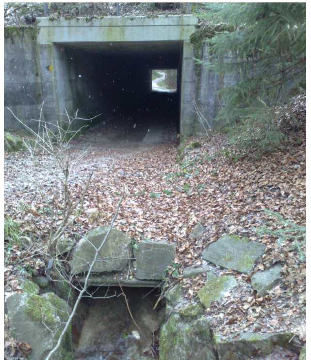
Foto 20-6: Bachdurchlass unter Autobahn: Bach mit Betonplatten abgedeckt
