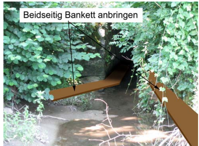
Foto 21-4: Dritter Gewässerdurchlass Waldibach an der Strasse Eschenbach – Rothenburg (Massnahme GD3)
