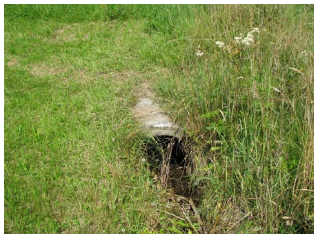
Foto 21-2: Zweiter Gewässerdurchlass Waldibach an der Strasse Eschenbach – Rothenburg (Massnahme GD2: Neubau des Gewässerdurchlasses, siehe auch Foto 21-3)
