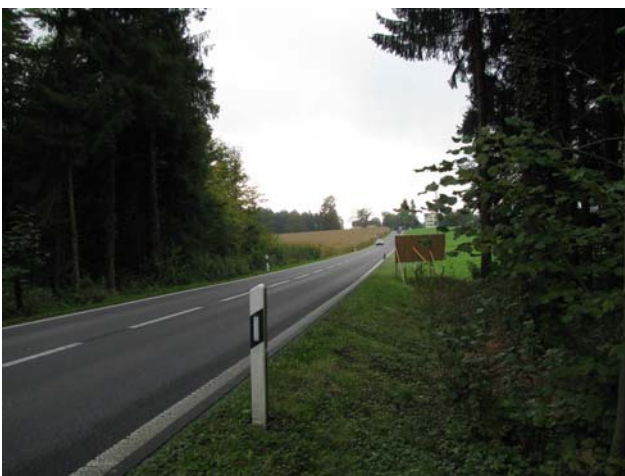
Foto 22-1: Kantonsstrasse K15 beim Engnis 22
