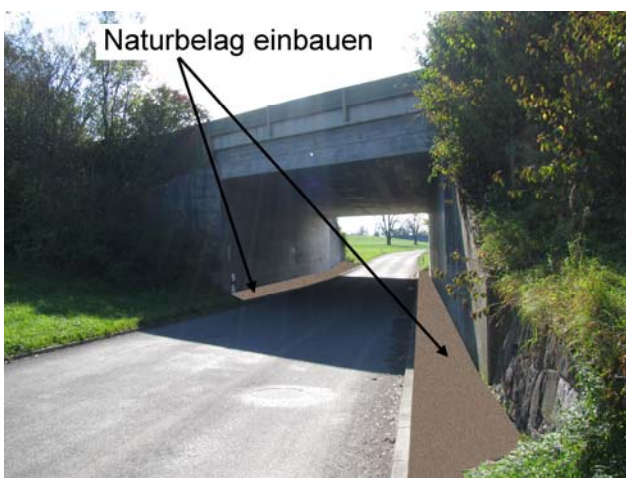
Foto 23-1: Unterführung Strasse Truttige-Mättiwil unter Autobahn A2 (Massnahme UF1)
