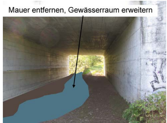
Foto 23-4: Gewässerdurchlass Kleine Aa unter Autobahn A2 (Massnahme GD1)
