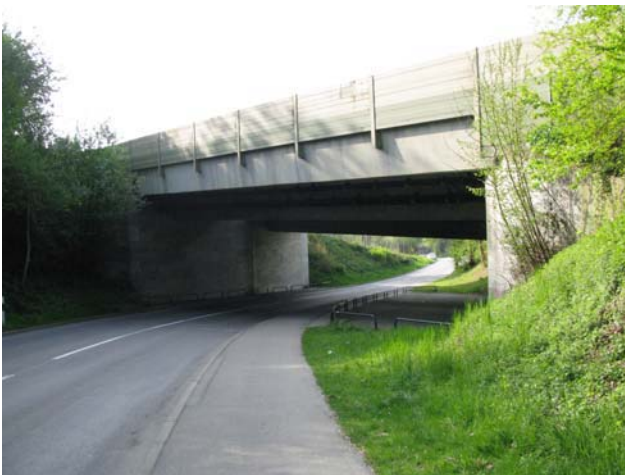
Foto 24-1: Unterführung Strasse Sempach – Beromünster unter A2 (Massnahme UF1: in heutigem Zustand belassen)
