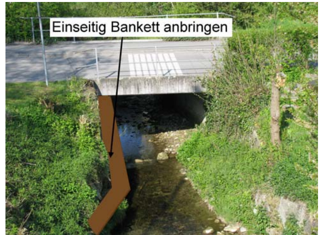
Foto 24-10: Gewässerdurchlass Meierhofbach unter der Schauenseestrasse im Wohngebiet Meierhof (Massnahme GD5)
