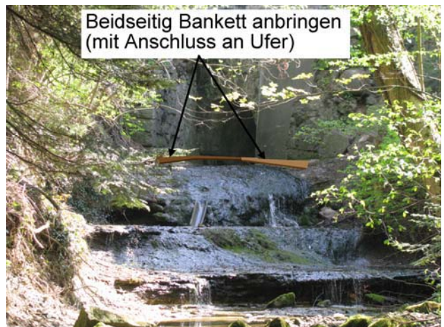
Foto 24-8: Massnahme GD3 an Gewässerdurchlass Kunzenbach bei Kantonsstrasse K56
