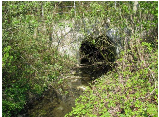
Foto 24-6: Gewässerdurchlass Kunzenbach bei Kantonsstrasse K56, östliche Durchlassseite
