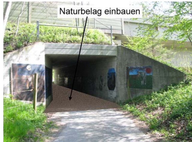
Foto 24-2: Unterführung Landwirtschaftsstrasse unter A2 (Massnahme UF2)
