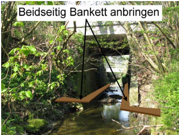
Foto 24-9: Gewässerdurchlass Meierhofbach unter Strasse Sempach – Beromünster (Massnahme GD4)
