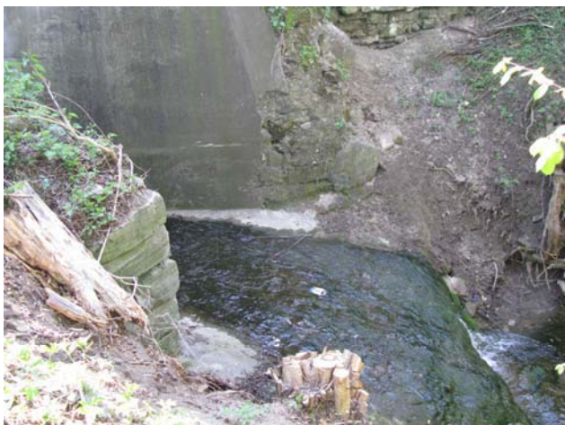
Foto 24-7: Gewässerdurchlass Kunzenbach bei Kantonsstrasse K56, westliche Durchlassseite
