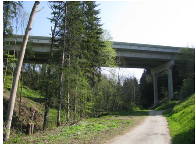
Foto 24-4: Autobahnviadukt (Massnahme GD1: in heutigem Zustand belassen)
