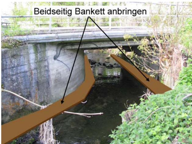
Foto 24-5: Gewässerdurchlass Meierhofbach bei Kantonsstrasse K48 (Massnahme GD2)
