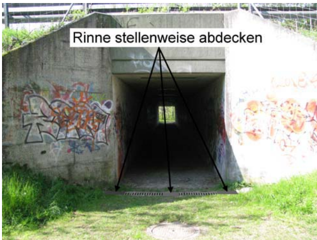
Foto 24-3: Personenunterführung unter A2 (Massnahme UF3)
