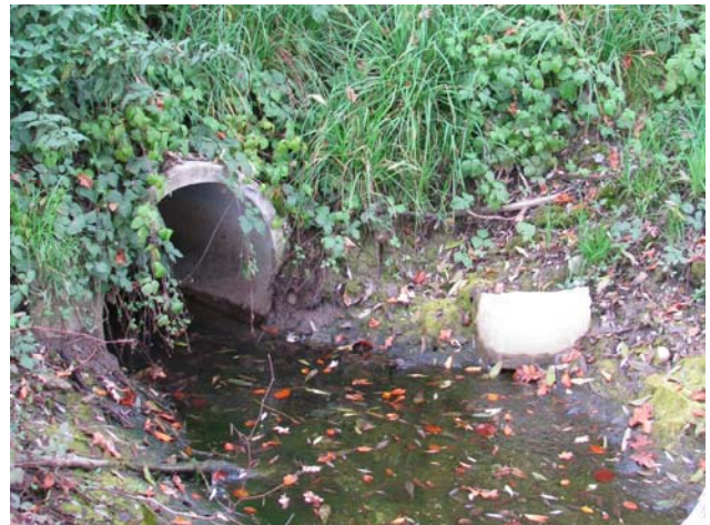
Foto 25-6: Rohrdurchlass Schiltbach beim Feldweg zum Perlenhof (Massnahme GD4)
