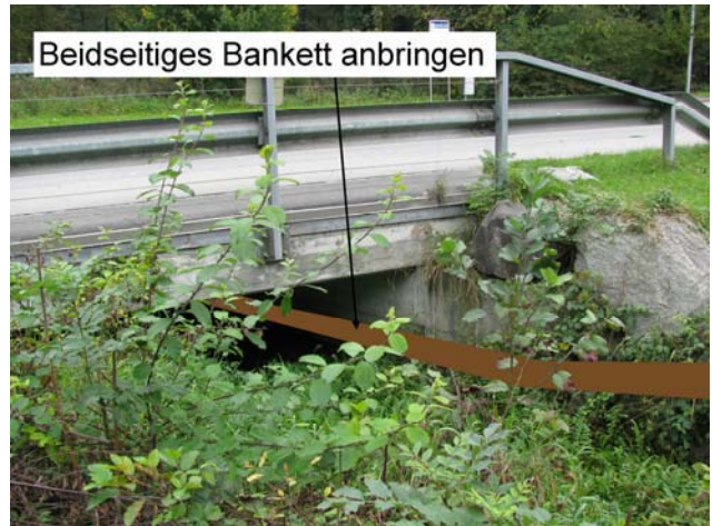
Foto 25-4: Gewässerdurchlass Sagenbach bei der Kantonsstrasse K65 (Massnahme GD3)
