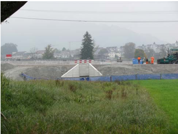
Foto 25-5: Gewässerdurchlass im Bau, beim neuen Autobahzubringer
