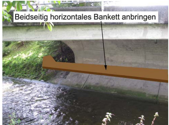
Foto 26-4: Gewässerdurchlass Rotbach an der Strasse Waltwil – Rüeggisingen (Massnahme GD3)
