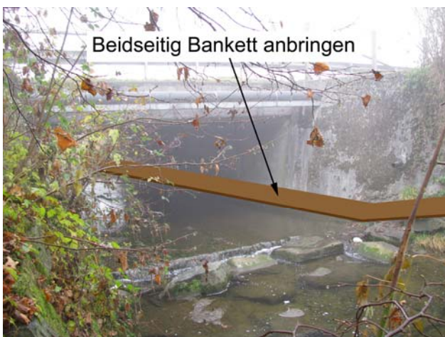
Foto 26-1: Gewässerdurchlass Rotbach an der Kantonsstrasse K16 und der Bahnlinie (Massnahme GD1)
