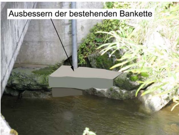
Foto 26-5: Gewässerdurchlass Rotbach am Abzweiger der Strasse Waltwil – Rüeggisingen (Massnahme GD4)
