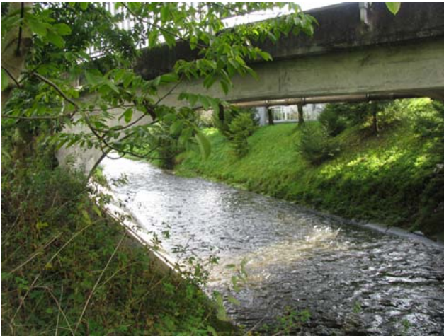
Foto 26-3: Gewässerdurchlass Rotbach an der Strasse Waltwil – Rüeggisingen
