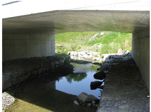
Foto 27-6: Gewässerdurchlasses Buzibach an der Autobahnabfahrt Nord (Massnahme GD3: in heutigem Zustand belassen)
