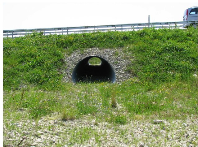
Foto 27-2: Kleintierdurchlass unter Autobahnauffahrt Nord (Massnahme UF2: in heutigem Zustand belassen)
