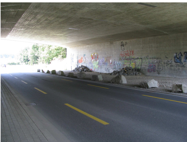
Foto 27-1: Unterführung Wahlggenstrasse unter Autobahn A2 (Massnahme UF1: in heutigem Zustand belassen)
