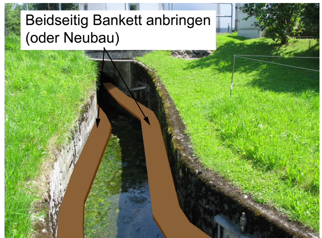
Foto 27-8: Gewässerdurchlass Buzibach an der Hasenmoosstrasse und der SBB (Massnahme GD5)
