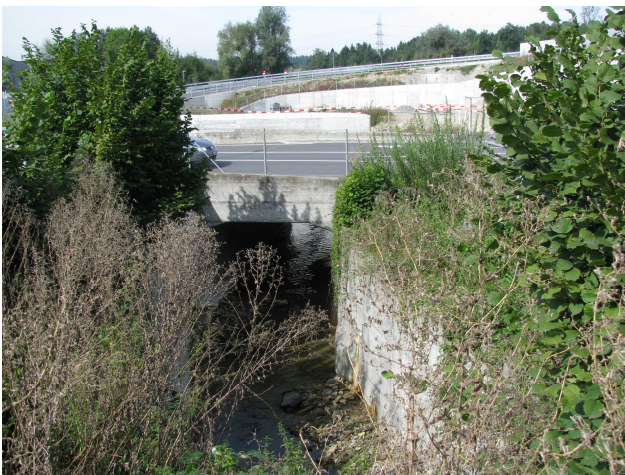
Foto 27-7: Gewässerdurchlasses Buzibach an der Kantonsstrasse K15a (Massnahme GD4: Kiesbankett ergänzen)
