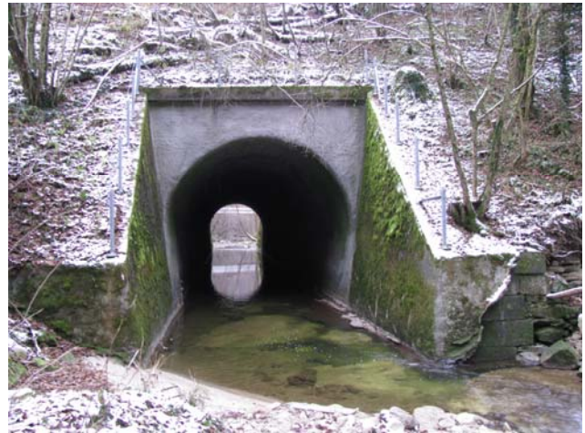
Foto 28-4: Gewässerdurchlass Rotbach der Eisenbahnlinie, Sanierungsprojekt SBB
