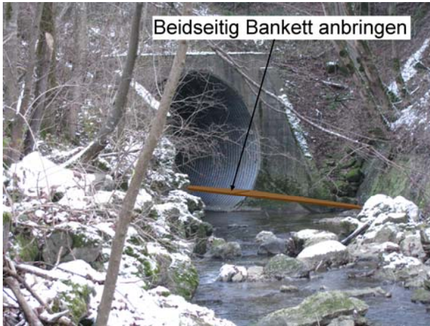
Foto 28-3: Gewässerdurchlass Rotbach bei Kantonsstrasse K13 (Massnahme GD2)
