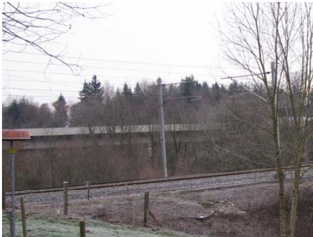
Foto 28-1: Eisenbahnlinie SBB mit Autobahnbrücke im Hintergrund
