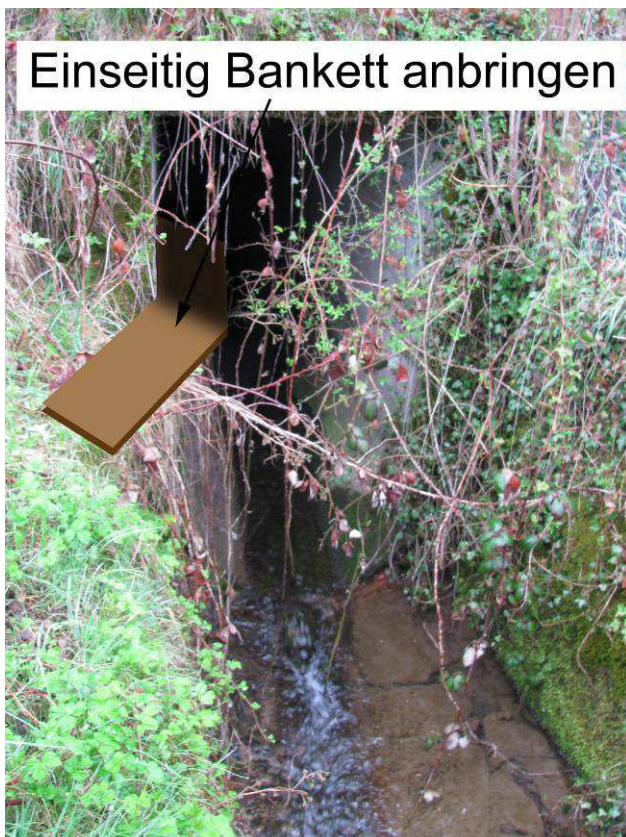
Foto 29-1: Gewässerdurchlass Kellenbach an der Kantonsstrasse K12 (Massnahme GD1)
