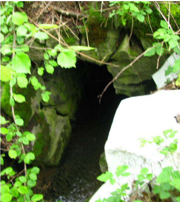
Foto 29-10: Gewässerdurchlass Limbach an der Strasse Hellbühl – Malters (Massnahme GD8: Neubau des Gewässerdurchlasses)
