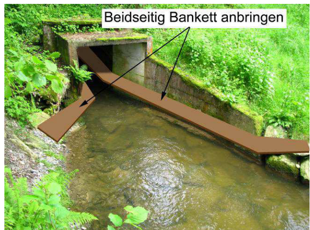
Foto 29-11: Gewässerdurchlass Rotbach an der Strasse Raage – Rüti (Massnahme GD9)
