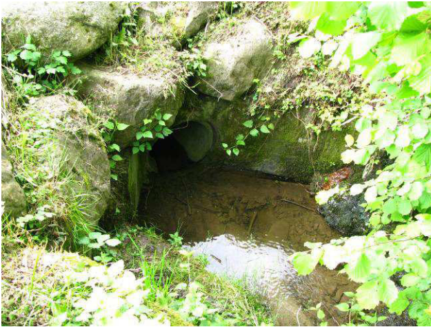
Foto 29-3: Gewässerdurchlass Seitenbach des Rotbachs an der Kantonsstrasse K12 (Massnahme GD2: Neubau des Gewässerdurchlasses)
