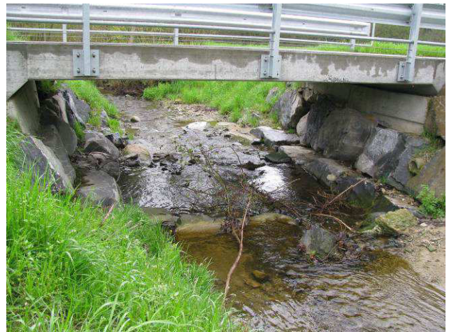
Foto 29-6: Gewässerdurchlass Kellenbach an der Strasse Moosschür – Sageli (Massnahme GD5: in heutigem Zustand belassen)
