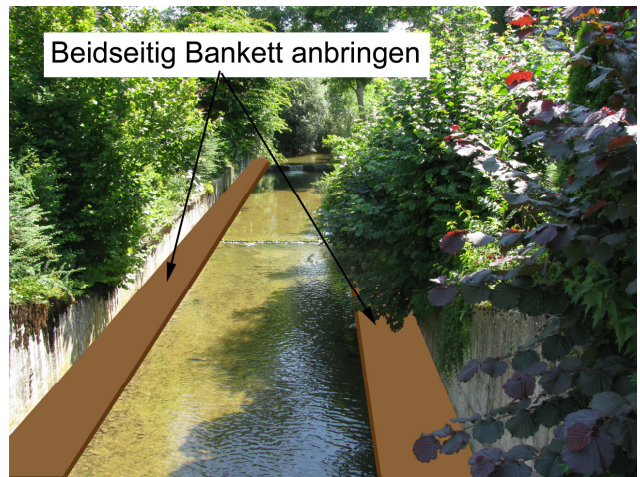
Foto 30-4: Bielbach unmittelbar oberhalb des Gewässerdurchlasses an der Rosswöschstrasse (Massnahme GD2)
