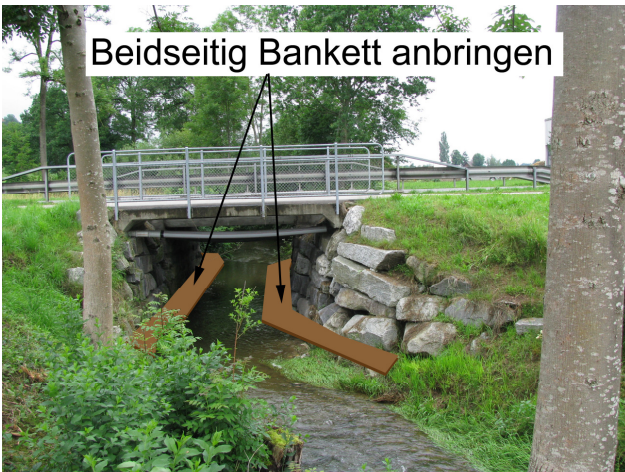
Foto 30-1: Gewässerdurchlass Bielbach an der Kantonsstrasse K34 (Massnahme GD1)
