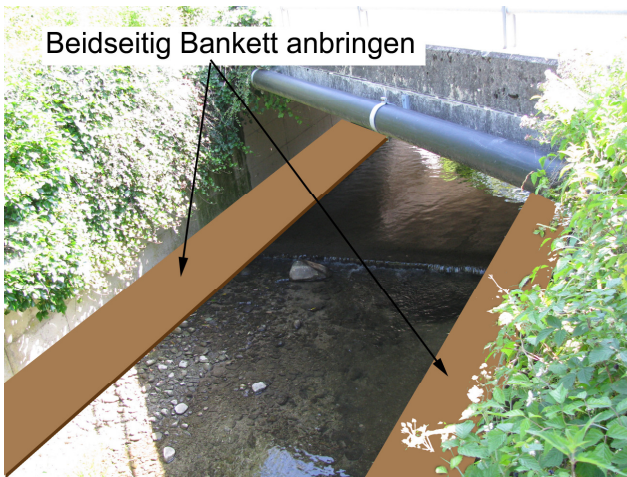
Foto 30-3: Gewässerdurchlass Bielbach an der Rosswöschstrasse (Massnahme GD2)
