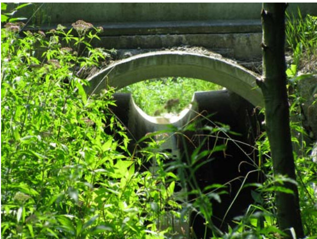
Foto 31-1: Gewässerdurchlass „Hangbach 1“ an der Kantonsstrasse K10 (Massnahme GD1)
