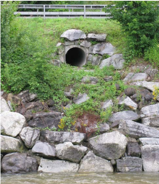
Foto 31-3: Gewässerdurchlass „Hangbach 2“ an der Kantonsstrasse K10 (Massnahme GD2)
