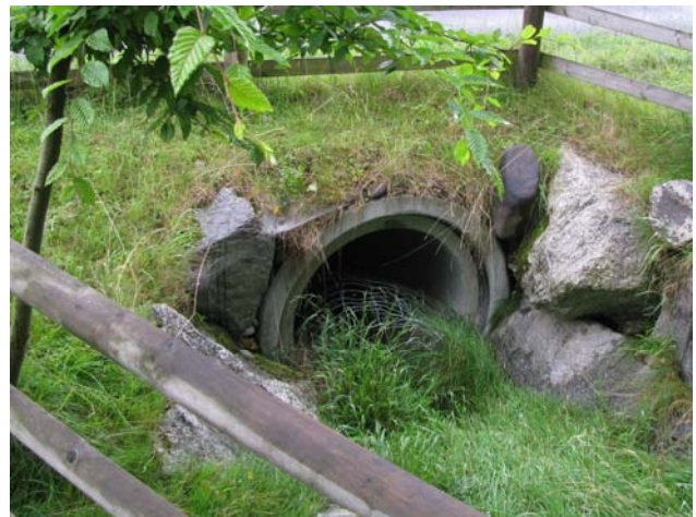
Foto 31-2: Gewässerdurchlass „Hangbach 2“ an der Kantonsstrasse K10 (Massnahme GD2)
