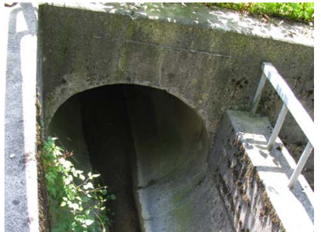
Foto 31-6: Gewässerdurchlasses „Hangbach 4“ an der Kantonsstrasse K10 (Massnahme GD4)
