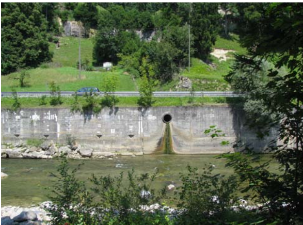
Foto 31-5: Gewässerdurchlasses „Hangbach 3“ an der Kantonsstrasse K10 (Massnahme GD3)
