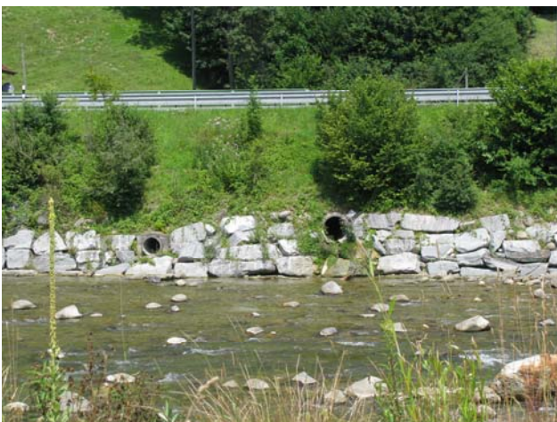
Foto 31-7: Gewässerdurchlasses „Hangbach 4“ an der Kantonsstrasse K10 (Massnahme GD4)
