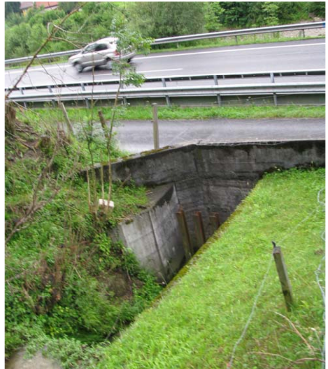
Foto 31-4: Gewässerdurchlasses „Hangbach 3“ an der Kantonsstrasse K10 (Massnahme GD3)
