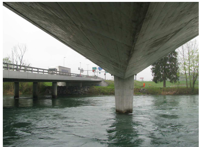
Foto 32-2: Gewässerdurchlass Reuss an der Kantonsstrasse K65 und bei der Fussgängerbrücke (Massnahme GD1: in heutigem Zustand belassen)
