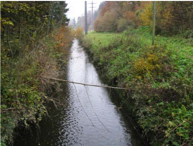
Foto 33-3: Unterwasserkanal Torenberg, Blickrichtung Südwesten (Massnahme GAU1: Uferverbauung entfernen)
