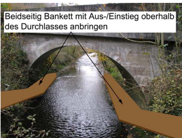
Foto 33-1: Gewässerdurchlass Unterwasserkanal bei der Strasse Burgschache – Obergadematt (Massnahme GD1)
