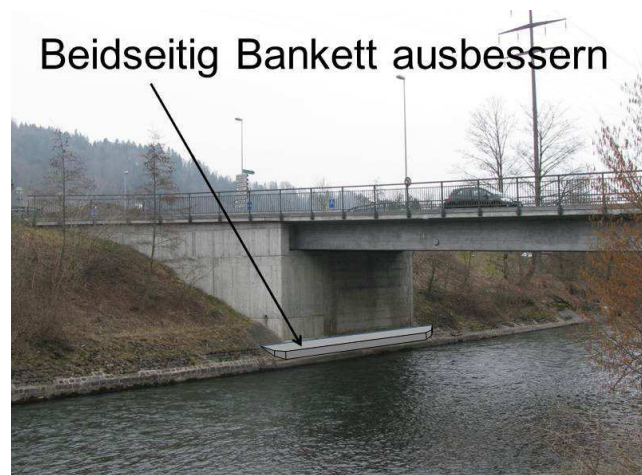
Foto 34-2: Gewässerdurchlass Kleine Emme an der Strasse Malters – Hellbühl (Massnahme GD1)
