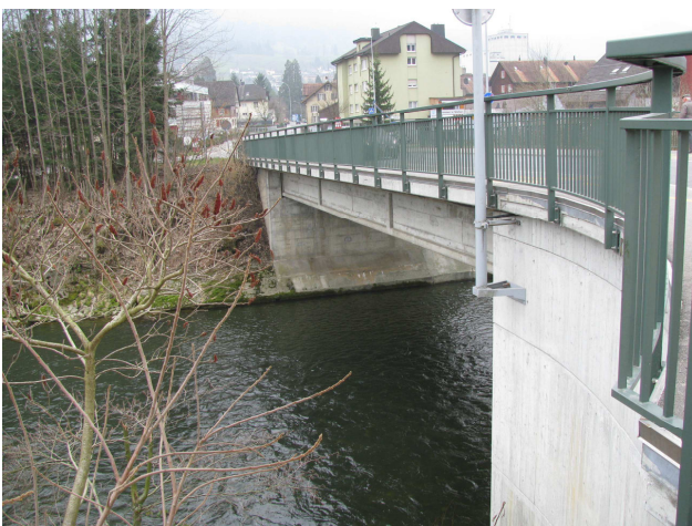
Foto 34-1: Gewässerdurchlass Kleine Emme an der Strasse Malters – Hellbühl
