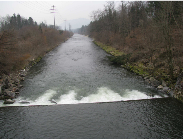
Foto 34-3: Absturz der Kleinen Emme in der Nähe des Gewässerdurchlasses an der Strasse Malters - Hellbühl (Massnahme GAG1: Absturz aufheben gemäss Artenhilfsprogramm Ringelnatter)
