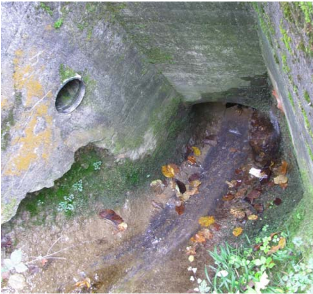
Foto 35-3: Gewässerdurchlass Hangbach an der Schwandenstrasse (Massnahme GD2: in heutigem Zustand belassen)
