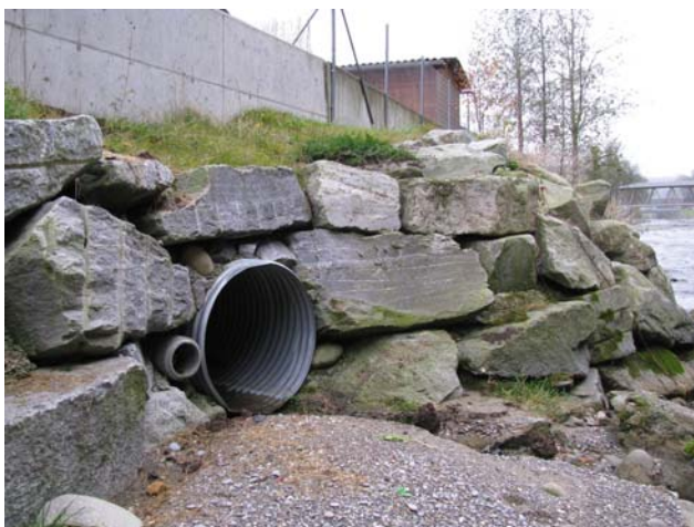
Foto 35-1: Gewässerdurchlass Ämserenbach an der Kantonsstrasse K10, Blickrichtung Osten
