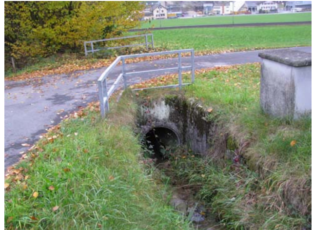
Foto 35-6: Gewässerdurchlass Ämserenbach an der Ämsererstrasse (Massnahme GD3: in heutigem Zustand belassen)
