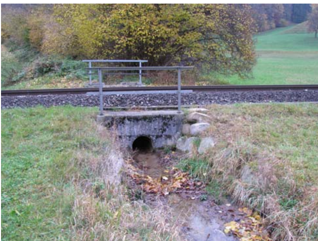
Foto 35-7: Gewässerdurchlass Ämserenbach an der Bahnlinie SBB (Massnahme GD2: in heutigem Zustand belassen)
