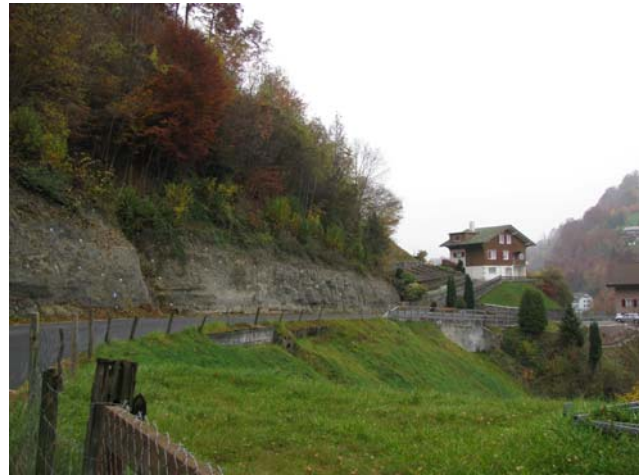
Foto 35-4: Schwandenstrasse im Bereich der Hangbäche
