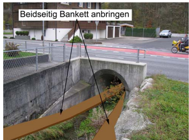
Foto 35-2: Gewässerdurchlass Ämserenbach an der Kantonsstrasse K10, Blickrichtung Westen (Massnahme GD1)
