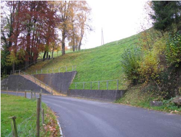
Foto 35-5: Schwandenstrasse im Bereich der Hangbäche
