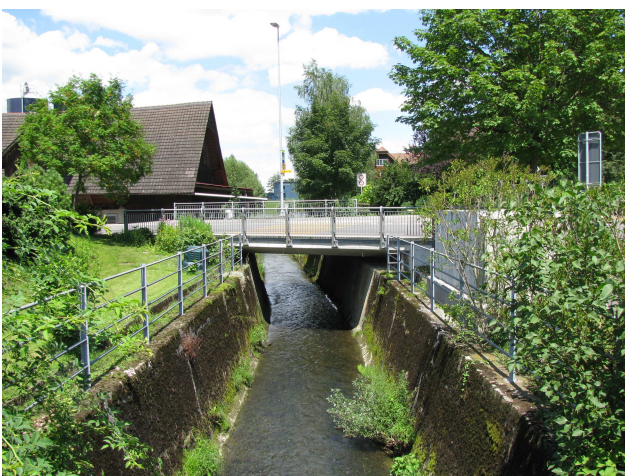
Foto 36-1: Gewässerdurchlass Ron an der Perlenstrasse (Massnahme GD1 bzw. GAU1, auf Fotos 36-8)
