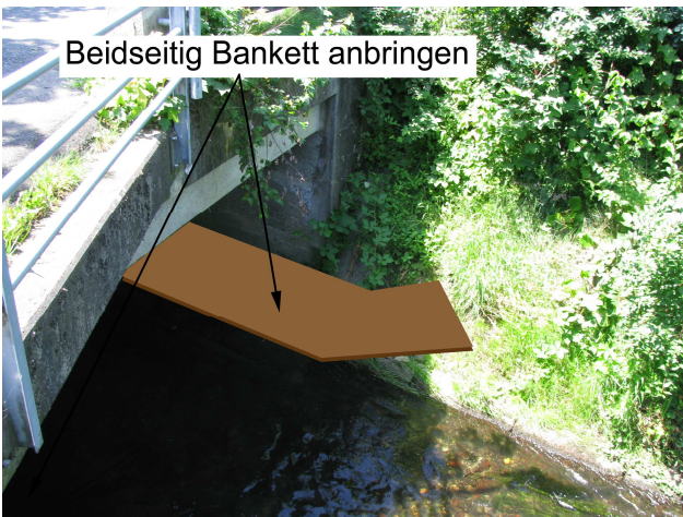
Foto 36-7: Gewässerdurchlass Ron im Siedlungsgebiet (Massnahme GD7)
