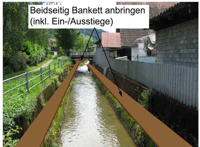
Foto 36-8: Kanalisierte Ron im Siedlungsgebiet (Massnahme GAU1)
