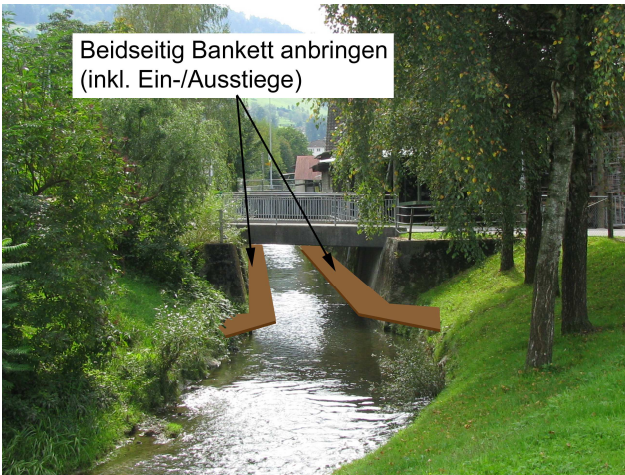
Foto 36-3: Gewässerdurchlass Ron im Siedlungsgebiet (Massnahme GD3 bzw. GAU1)
