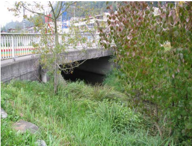
Foto 37-3: Gewässerdurchlass Ron bei Risch - Sonnhalde
