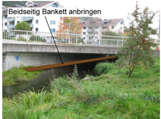
Foto 37-4: Gewässerdurchlass Ron bei Risch - Sonnhalde (Massnahme GD2)
