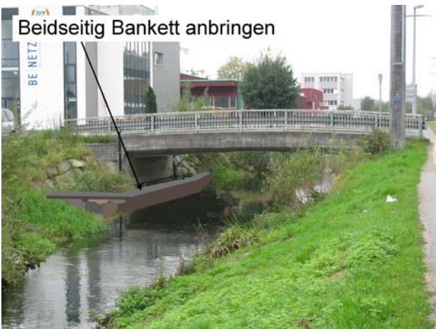
Foto 37-7: Gewässerdurchlass Ron zwischen Ronstrasse und Industriestrasse (Massnahme GD4)
