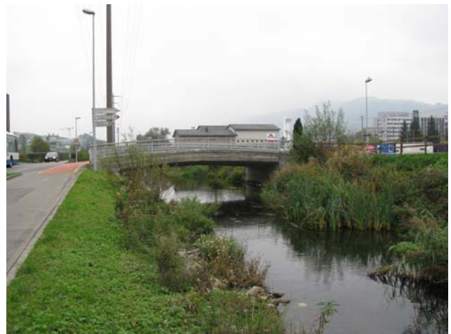
Foto 37-6: Gewässerdurchlass Ron zwischen Ronstrasse und Industriestrasse
