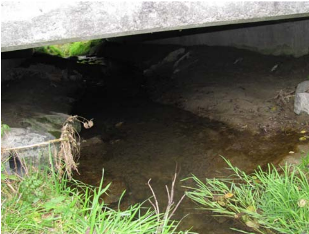
Foto 38-13: Gewässerdurchlass Wiesbach unter Eisenbahn (Massnahme GD4: Gewässerdurchlass in heutigem Zustand belassen)
