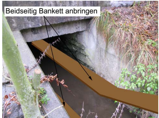
Foto 38-8: Gewässerdurchlass Götzenbach unter Kantonsstrasse K17b (Massnahme GD8)
