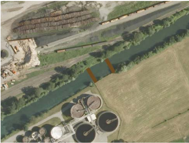
Foto 38-15: Neubau von Überführungen für Kleintiere über den Kanal (Massnahme NB3)
