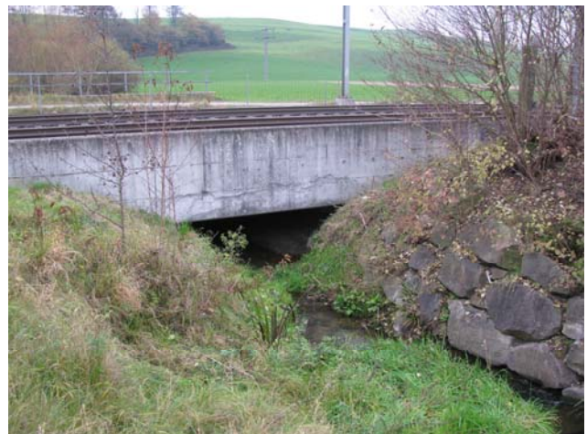
Foto 38-12: Gewässerdurchlass Wiesbach unter Eisenbahn
