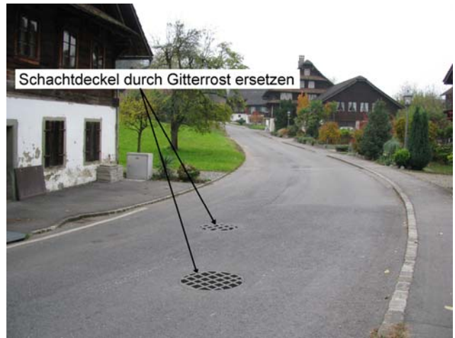
Foto 38-20: Gewässerdurchlässe Götzentalbach im Siedlungsgebiet Dörfli (Massnahme GD11 bzw. GD12)
