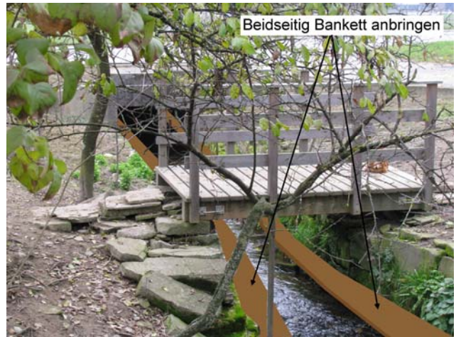
Foto 38-4: Gewässerdurchlass Götzentalbach unter Kantonsstrasse K17 (Massnahme GD3)
