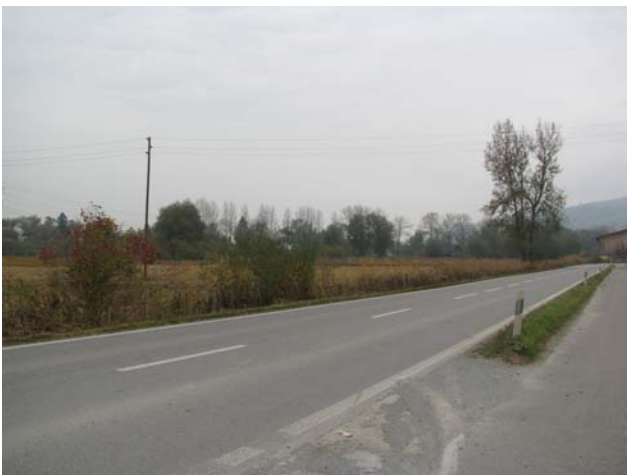
Foto 38-11: Strasse durch Industriegebiet Perlen (Massnahme NB2: mehrere Kleintierdurchlässe neu schaffen)
