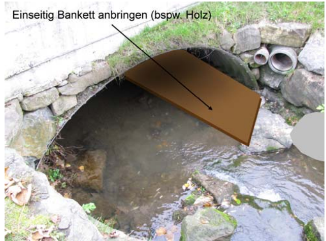
Foto 38-2: Gewässerdurchlass Wiesbach unter Kantonsstrasse K17 (Massnahme GD1)
