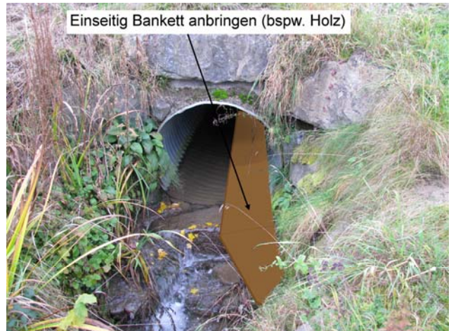
Foto 38-6: Gewässerdurchlass Charenbach unter Kantonsstrasse K17b (Massnahme GD6)
