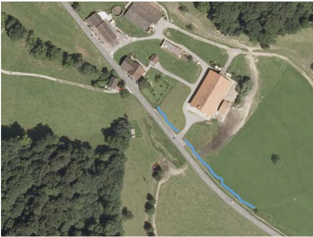
Foto 38-9: Neubau eines Gewässerdurchlasses unter der Bauernhofzufahrt durch (Massnahme NB1)
