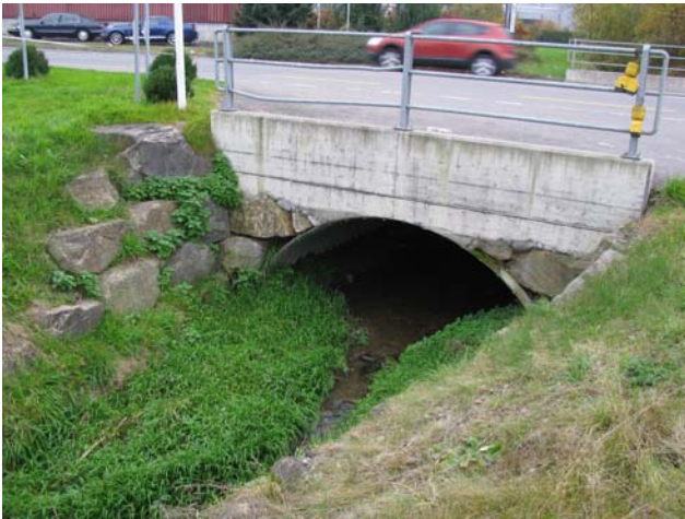
Foto 38-1: Gewässerdurchlass Wiesbach unter Kantonsstrasse K17
