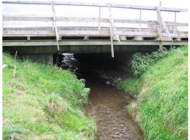
Foto 38-14: Gewässerdurchlass Götzentalbach unter Eisenbahn (Massnahme GD5: Durchlass in heutigem Zustand belassen)
