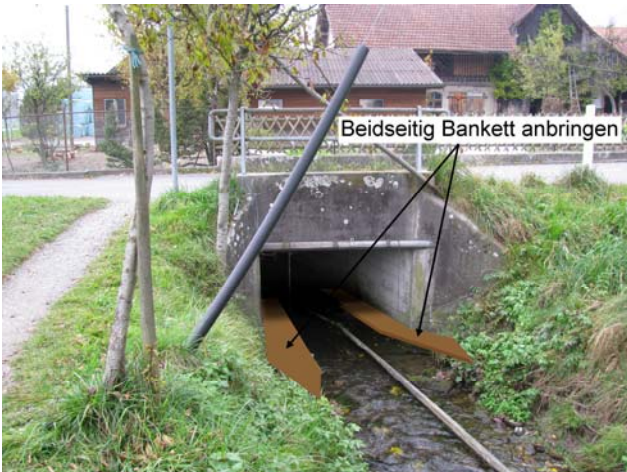
Foto 38-5: Gewässerdurchlass Götzentalbach unter Seitenstrasse bei Bauernhof (Massnahme GD10)
