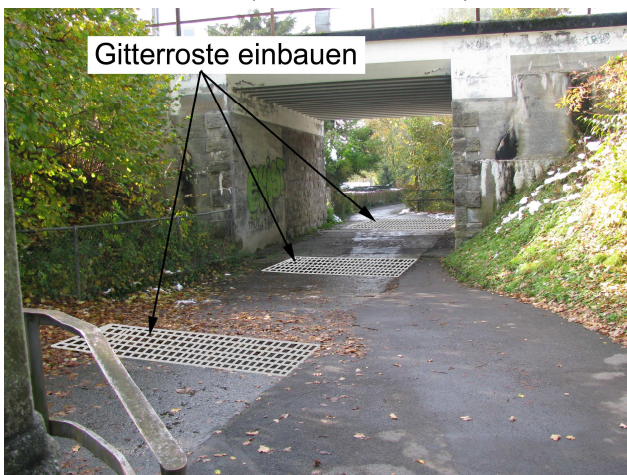
Foto 39-7: Eisenbahnunterführung, Würzenbach verläuft unterirdisch (vgl. Foto 39-6, Massnahme GD6)
