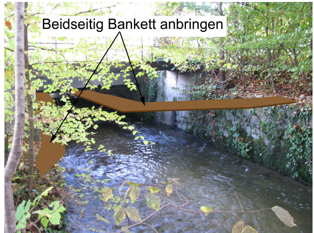
Foto 39-4: Gewässerdurchlass Würzenbach an der Würzenbachstrasse (Massnahme GD4)
