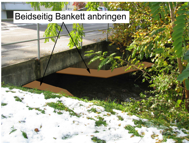
Foto 39-5: Gewässerdurchlass Würzenbach an der Würzenbachstrasse (Massnahme GD5)
