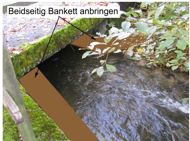
Foto 39-6: Gewässerdurchlasses Würzenbach in der Eisenbahnunterführung (Massnahme GD6)
