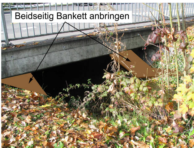
Foto 39-1: Gewässerdurchlass Würzenbach an der Kantonsstrasse K2 (Massnahme GD1)
