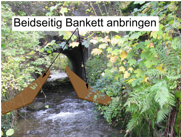
Foto 39-3: Gewässerdurchlass Würzenbach an der Kreuzbuchstrasse (Massnahme GD3)
