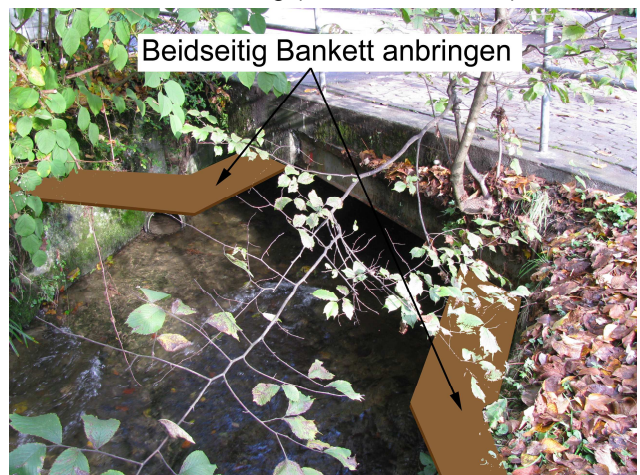
Foto 39-8: Gewässerdurchlass Würzenbach im Siedlungsgebiet Hinder Würzenbach (Massnahme GD7)
