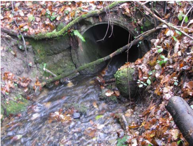
Foto 40-3: Zweiter Gewässerdurchlass Meggerwaldbach an der Strasse Sagenhof – Tschädigen (Massnahme GD3: Neubau)
