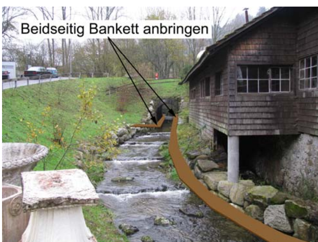
Foto 40-1: Gewässerdurchlass Würzenbach an der Strasse Sagenhof – Tschädigen (Massnahme GD1)
