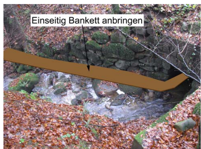
Foto 40-2: Erster Gewässerdurchlass Meggerwaldbach an der Strasse Sagenhof – Tschädigen (Massnahme GD2)
