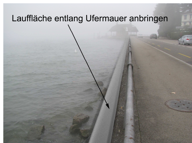
Foto 41-2: Seeufer im Bereich der Kantonsstrasse K2 (Massnahme GAU1)
