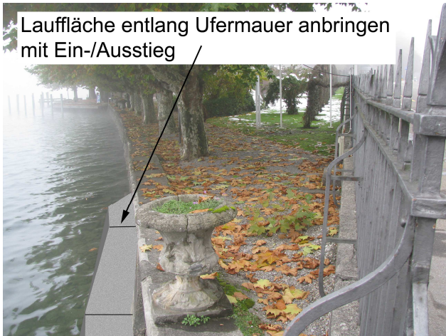
Foto 41-5: Seeufer im Bereich der Kantonsstrasse K2 (Massnahme GAU1)
