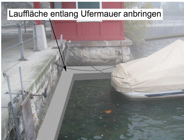
Foto 41-3: Seeufer im Bereich der Schifflanlegestelle Seeburg (Massnahme GAU1)
