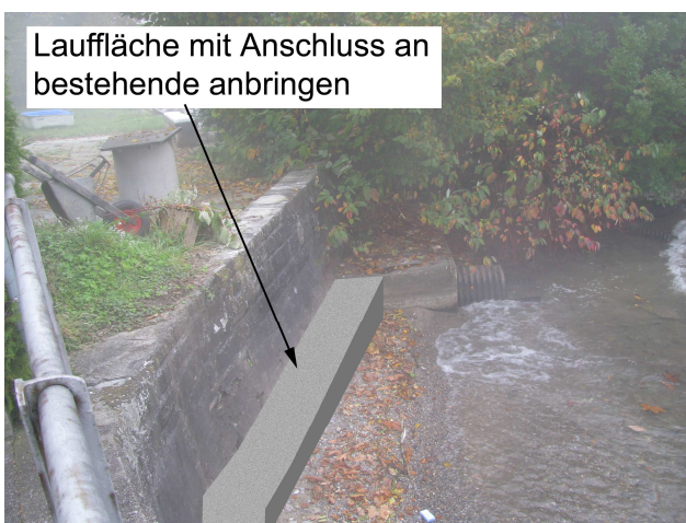
Foto 41-1: Seeufer im Bereich der Kantonsstrasse K2 (Massnahme GAU1)
