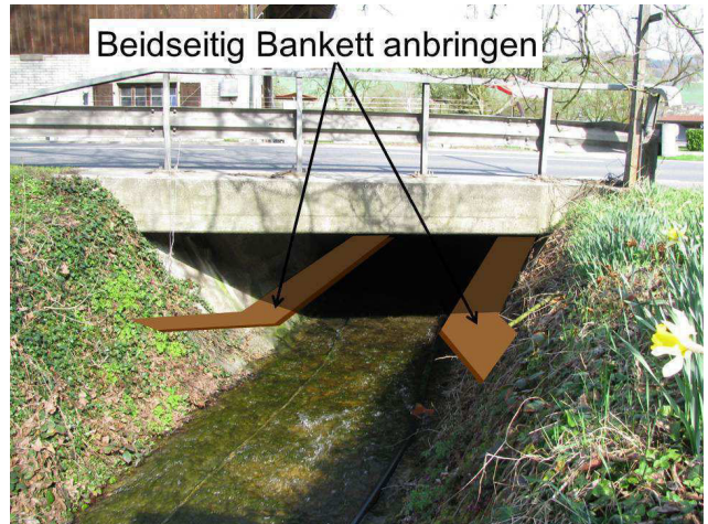
Foto 42-4: Gewässerdurchlass Widenbach an der Kantonsstrasse K2b (Massnahme GD2)
