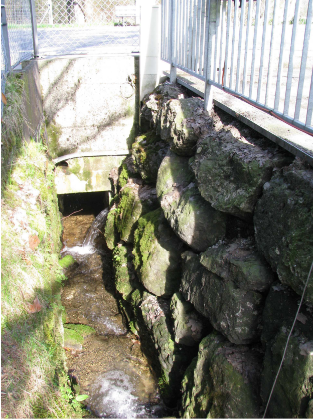
Foto 42-1: Gewässerdurchlass Scheidbach an der Kantonsstrasse K2b (Massnahme GD1: in heutigem Zustand belassen)
