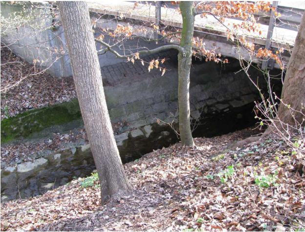
Foto 42-5: Gewässerdurchlass Rubibach an der Kantonsstrasse K2b
