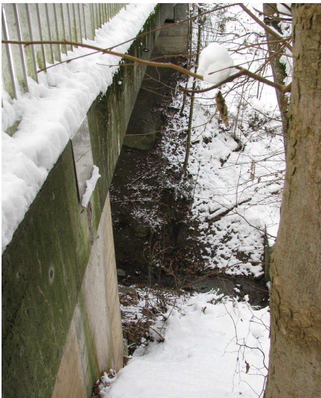
Foto 43-1: Gewässerdurchlass Bachtelbach an der Strasse Luzern – St. Niklausen (Massnahme GD1: Durchlass in heutigem Zustand belassen)
