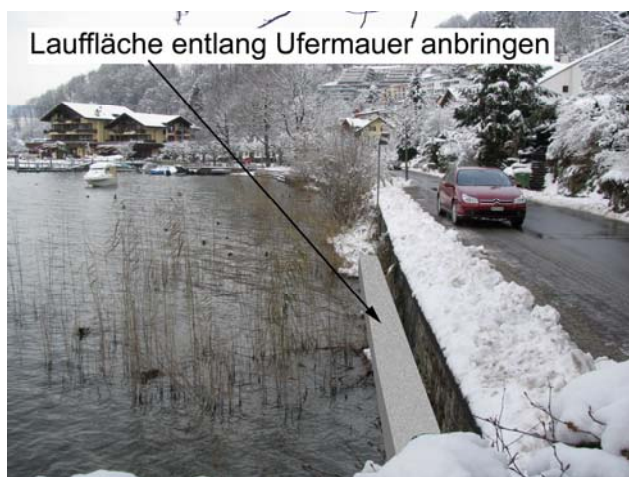
Foto 44-1: Ufermauer an der Strasse Horw - Kastanienbaum im Gebiet Winkel (Massnahme GAU1)
