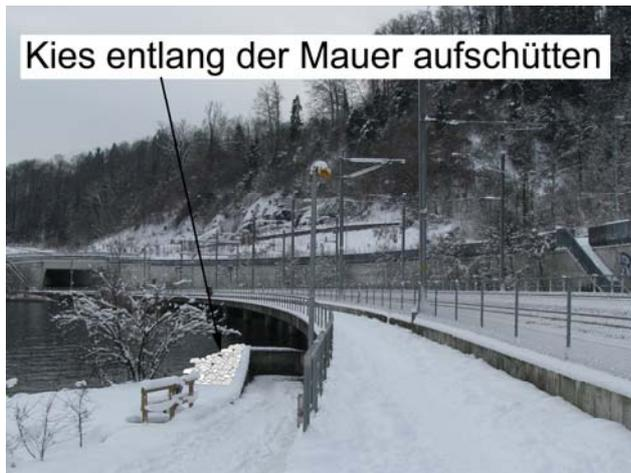
Foto 45-3: Eisenbahnbrücke und Fussgängerunterführung (Massnahme GAU1)
