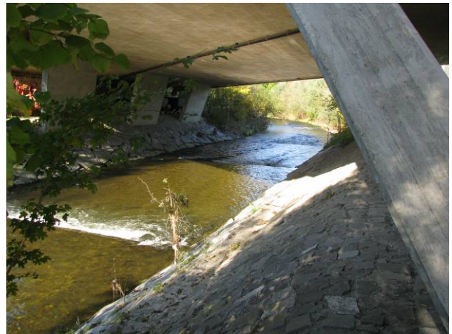
Foto 46-2: Gewässerdurchlass der Wigger unter der Autobahn A2
