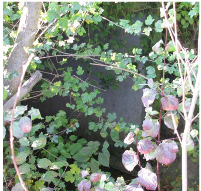
Foto 46-6: Gewässerdurchlass Luterbächli an der Kantonsstrasse K13 (Massnahme GD3: Beidseitig Bankett anbringen bzw. Neubau des Durchlasses in Zusammenhang mit Bachausdolung AD1)
