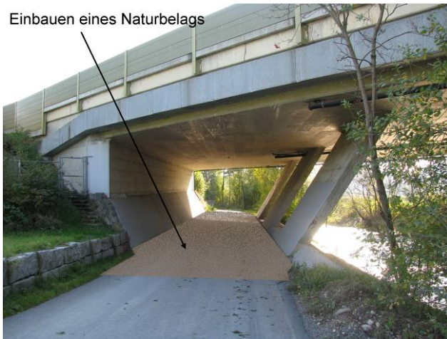
Foto 46-3: Gewässerdurchlass der Wigger unter der Autobahn A2 (Massnahme GD1)
