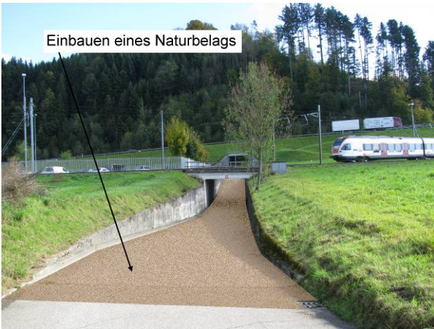
Foto 46-7: Unterführung Eisenbahn (Massnahme UF2)
