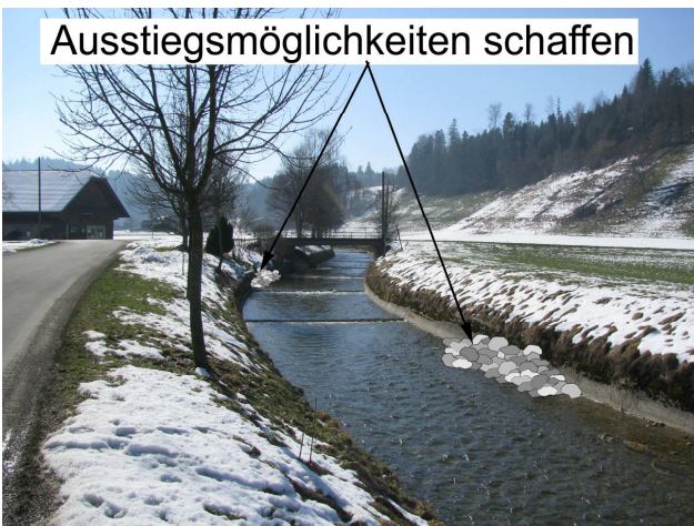
Foto 47-7: Verbaute Ufer entlang der Luthern (Massnahme GAU3)
