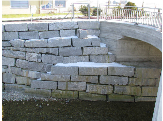
Foto 47-4: Gewässerdurchlass Luthern an der Strasse Gläng – Glängweid (Massnahme GD3: in heutigem Zustand belassen)
