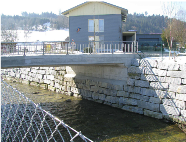
Foto 47-5: Gewässerdurchlass Luthern an der Strasse Gläng – Glängweid (Massnahme GD3: in heutigem Zustand belassen)
