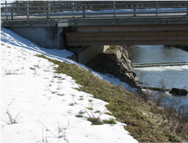
Foto 47-3: Gewässerdurchlass Luthern an der Kantonsstrasse K43a (Massnahme GD2: in heutigem Zustand belassen)
