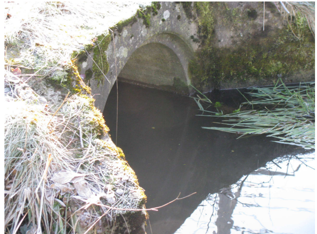
Foto 48-6: Gewässerdurchlass "Ziegeleibach" bei der Zufahrt zum Industriegebiet Hofmatt (Massnahme GD3: in heutigem Zustand belassen)
